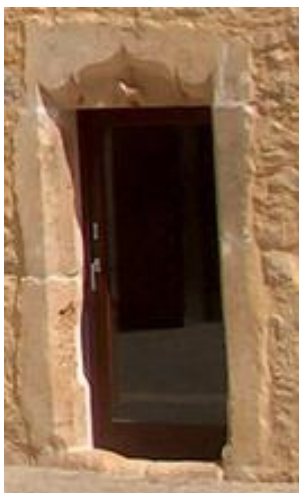
Figura 21: Janela da torre do paço dos Vasconcelos
