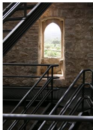
Figura 44: intervenção na torre com elementos metálicos
