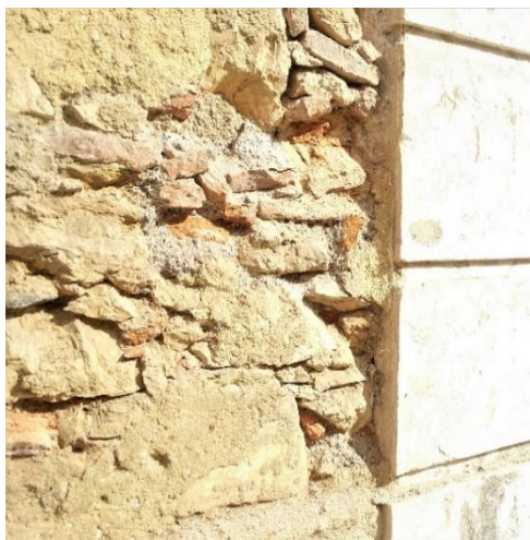
Figura 20: Alvenaria de pedra ordinária
