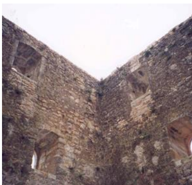
Figura 42: Interior da torre desde a sua originalidade
