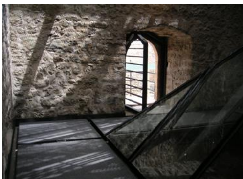
Figura 45: Estrutura metálica em forma piramidal
