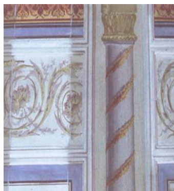
Figura 57: elementos pictóricos das paredes
