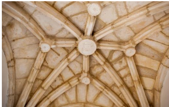
Figura 49: Cobertura ogival da capela
