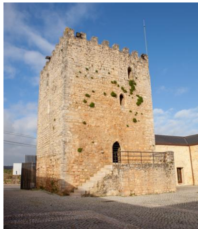
Figura 48: Reconstrução da escadaria de pedra
