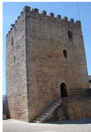
Figura 41: Torre apos ser recuperada
