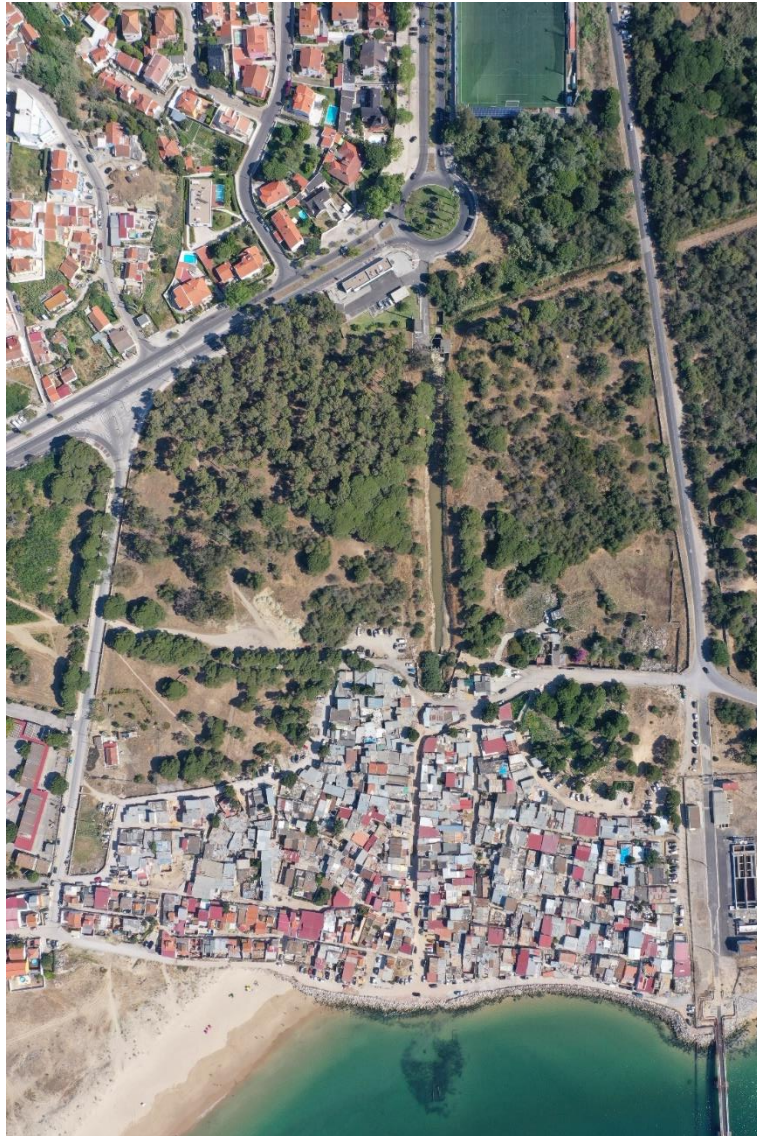
Fig. 6 A valla e o Bairro O conflito entre o assentamento de casas e a linha de água já coberta.
