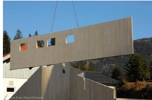
Figura 6 - Construção em CLT (Storaenso, 2019)
