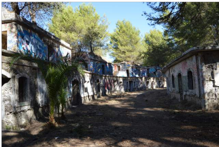
Figura 34 – Exterior. Vista geral da fachada O, 2019. Fotografia do autor.
