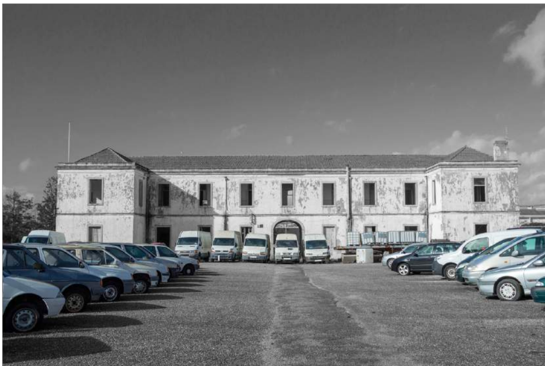
Figura 24 - Antigo Quartel de Artilharia nº 4 usado para depósito de viaturas, 2019.
