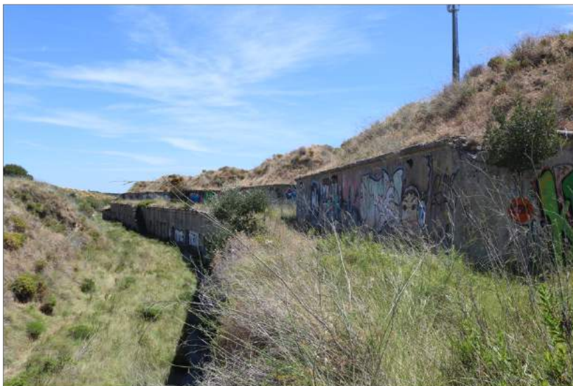
Figura 68 – Exterior. Segundo patamar da Bateria de Alpena, 2019. Fotografia do autor.
