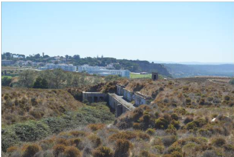
Figura 67 – Exterior. Vista sul (S) da Bateria de Alpena, 2019. Fotografia do autor.
