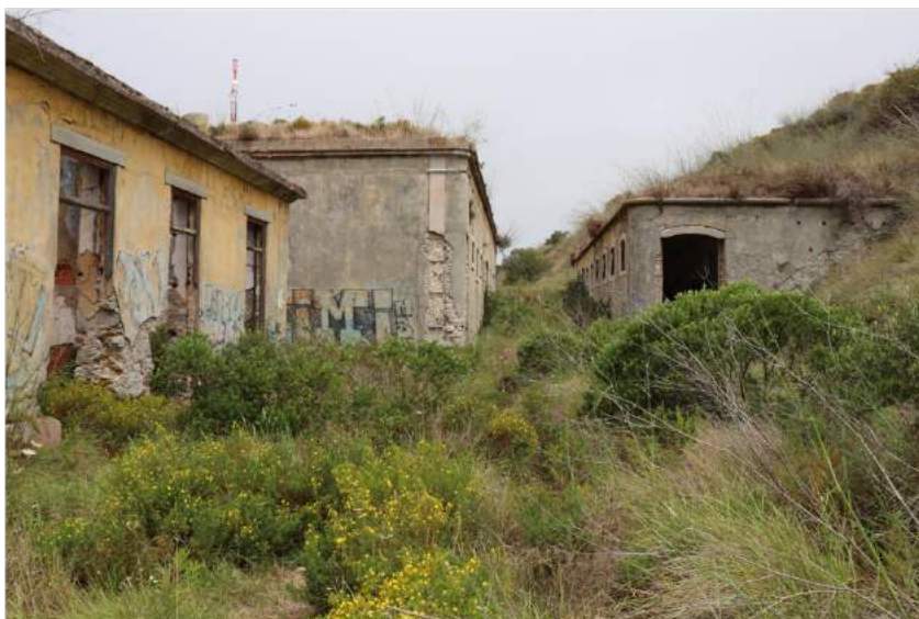
Figura 50 – Exterior. Zona do antigo pavilhão para oficiais e serviços gerais, 2019. Fotografia do autor.
