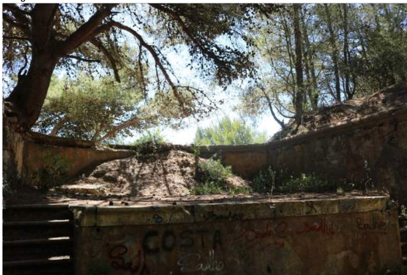
Figura 62 – Exterior. Patamar intermédio da Bateria da Raposeira I, 2019. Fotografia do autor.
