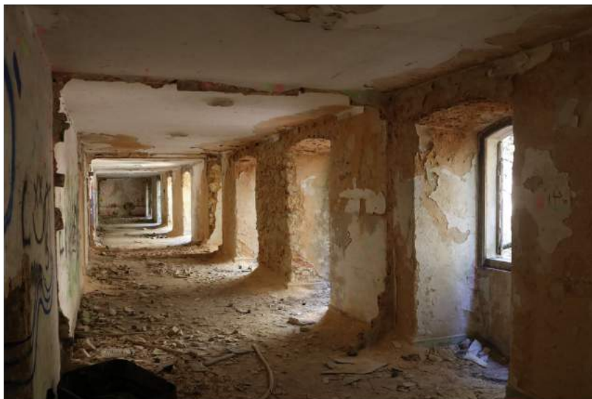
Figura 41 – Interior. Piso térreo da Bateria da Raposeira II, 2019. Fotografia do autor.
