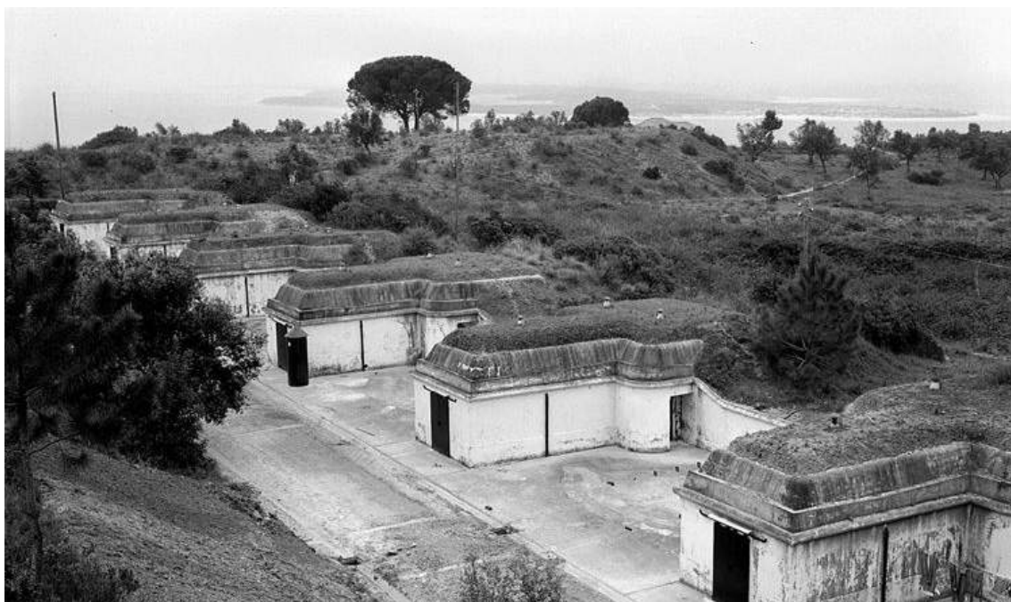
Figura 09 - Bateria do Casalinho, 1962. Vista geral dos paióis.
