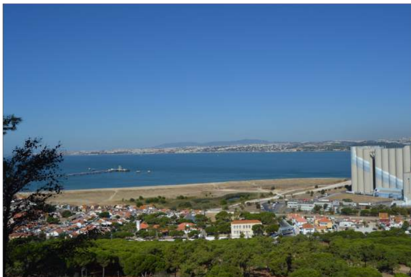
Figura 55 – Exterior. Vista norte (N) observada da Bateria da Raposeira I, 2019. Fotografia do autor.
