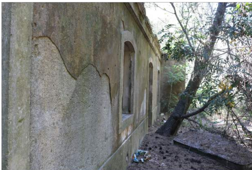
Figura 64 – Exterior. Patamar de entrada da Bateria da Raposeira II, 2019. Fotografia do autor.
