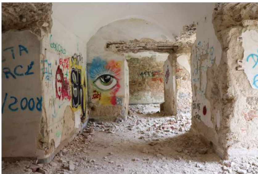
Figura 51 – Interior. Antigo paiól da Bateria de Alpena, 2019. Fotografia do autor.
