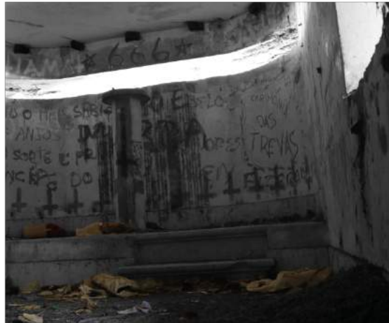
Figura 27 - Lixo existente no interior da II Bateria da Raposeira, 2019.
