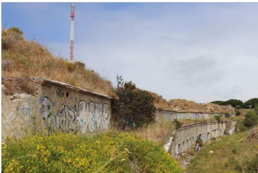
Figura 48 – Exterior. Fachada O da Bateria de Alpena, 2019. Fotografia do autor.
