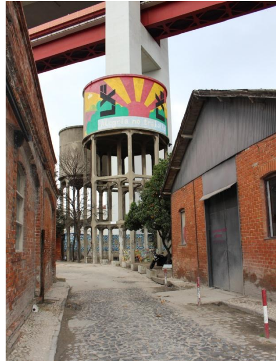
Figura 51 - Antigo reservatório de água ainda presente no espaço exterior do complexo. (Fotografia da autora; Data: 2016).
