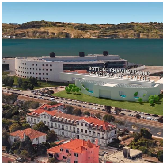
Figura 82 – Render do projeto de ampliação para o novo centro pancreático. (Imagem disponível na WEB: https://www.fchampalimaud.org/noticias/single/noticia-21 ).
