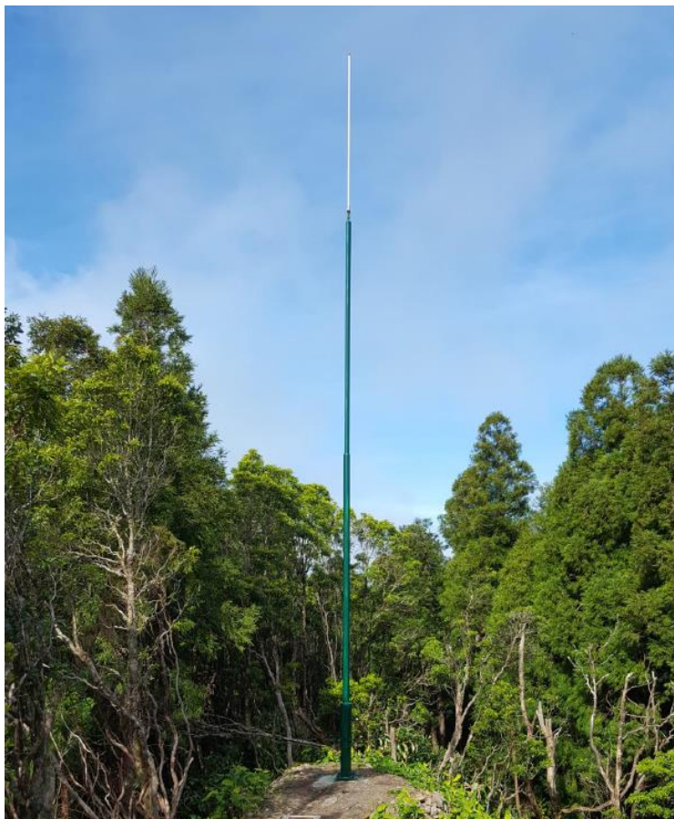
Figura I.2 - Reestruturação Pico Alto - Mastro 1
