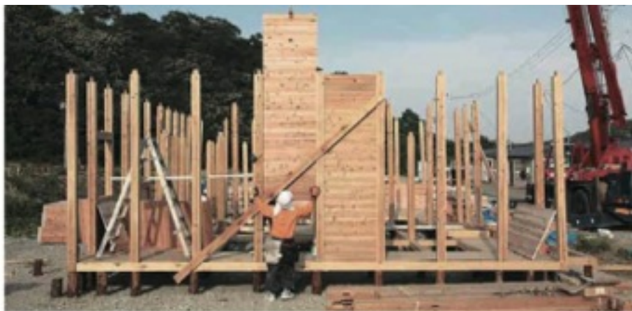
飯沼建設による被災者住宅建設支援プロジェクト/岡山建築研究所
