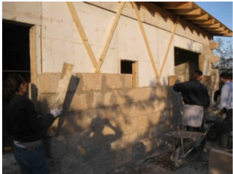
Fig.4 construção, blocos de cânhamo
