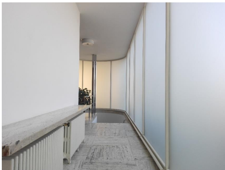
Figura 156 – Vista do corredor da figura anterior em direção às escadas de acesso ao piso inferior, 2019.
