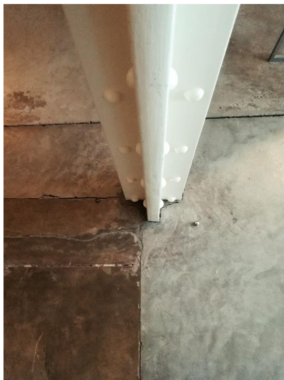
Figura 178 – As colunas neste espaço, apesar de pintadas, apresentam-se praticamente a 'cru', com os parafusos/uniões à vista, 2019.
