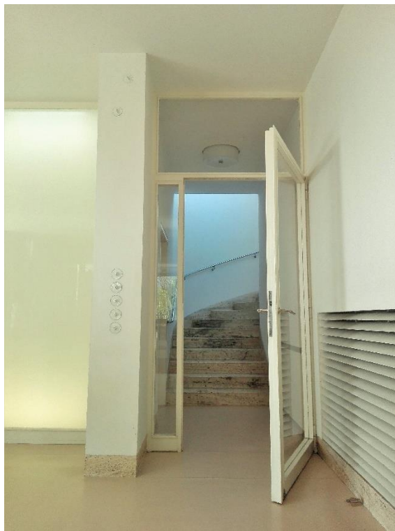
Figura 160 – Porta de acesso às áreas comuns do piso intermédio, 2019.
