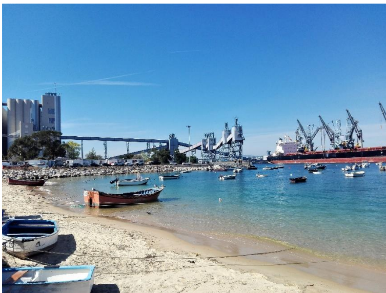
Figura 222 – Infraestrutura Portuária (Silopor), praia e atual zona fundeadouro, Trafaria, 2019.
