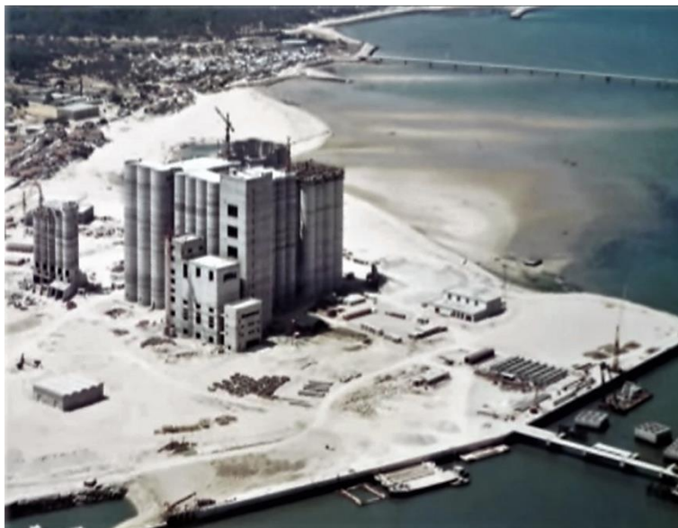
Figura 213 - Construção do Terminal de Granéis, início da década de 1980.
