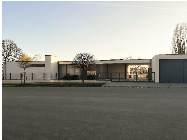
Figura 136 – Vista da rua para a zona de entrada da Casa Tugendhat, 2019.
