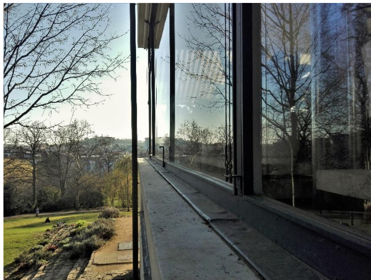
Figura 184 – Fachada da zona do jardim de inverno, 2019.
