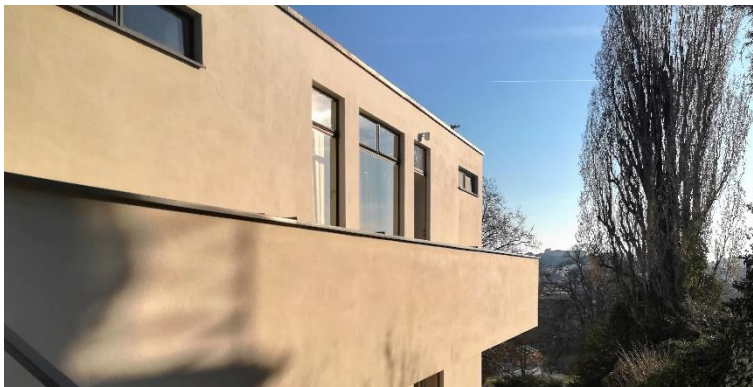
Figura 189 – Zona da escadaria da entrada secundária para a propriedade, de acesso em cima ao apartamento do motorista pela galeria e em baixo acesso aos quartos dos empregados, e seguidamente, à cozinha, 2019.
