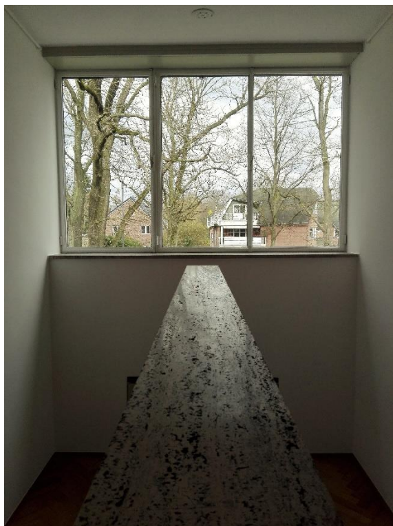
Figura 106 – Vão que ilumina as escadas de acesso ao piso superior, 2019.
