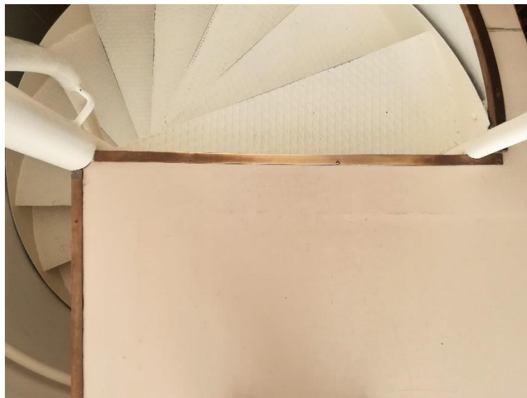
Figura 175 – Escadas metálicas em caracol de acesso à cave, 2019
