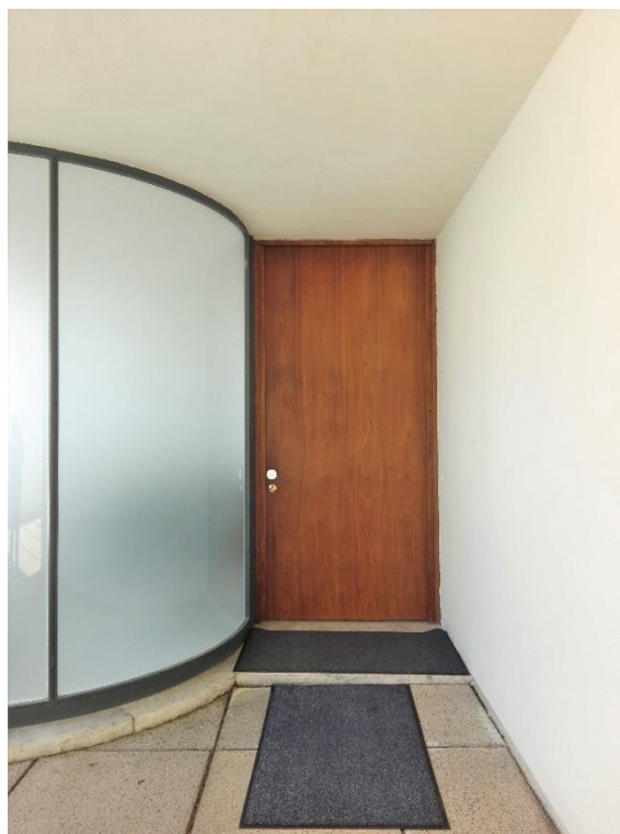
Figura 140 – Porta de entrada principal, 2019.
