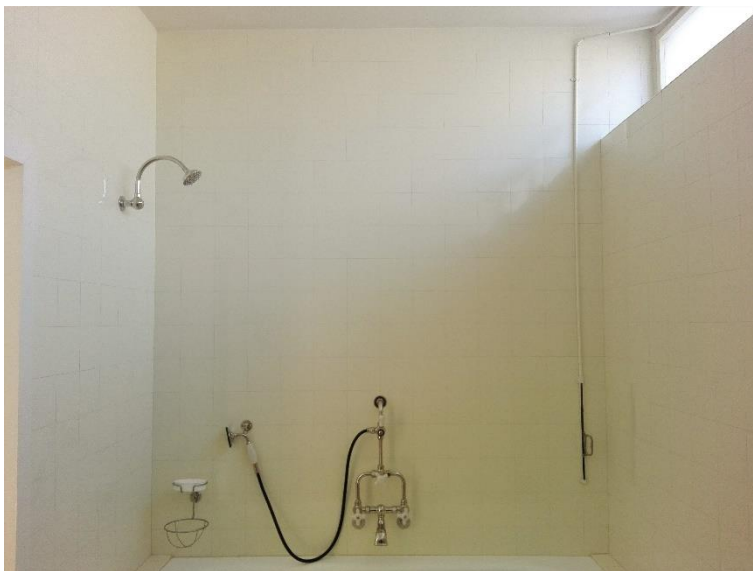
Figura 154 – Casa de banho comum, de apoio aos quartos das crianças e da ama, 2019.
