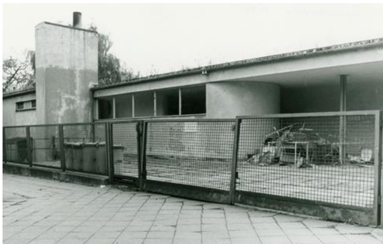
Figura 79 – Estado da Casa Tugendhat em 1980, antes da primeira grande renovação. As principais diferenças com a construção original, cingem-se nesta fotografia, principalmente ao aumento da chaminé em altura, ao remate da cobertura, e com maior evidência, ao local onde existia o plano de vidro leitoso, onde aparece uma parede em alvenaria de tijolo.
