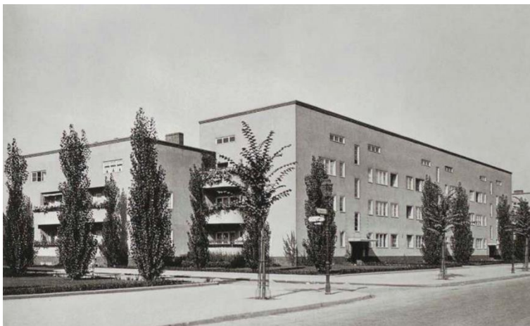
Figura 30 – Fotografia de parte do conjunto de edifícios de habitação na Afrikanischestrasse, algum tempo depois da sua construção em 1927.
