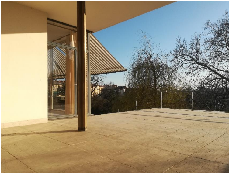
Figura 187– Acesso ao podium pelo interior, 2019.
