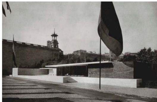
Figuras 43 e 44 – Pavilhão Alemão em Barcelona. Em cima, desenho da planta livre (in)definida por planos. Em baixo, fotografia após a construção para a exposição, 1929.
