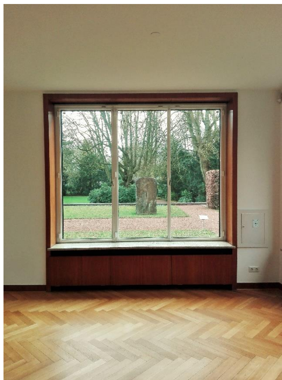
Figura 120 – Sala do senhor, 2019. Nota para os caixilhos nesta casa, pois não são de vidro único como na casa Lange. Apresentam-se aqui com várias folhas de vidro de abertura manual.
