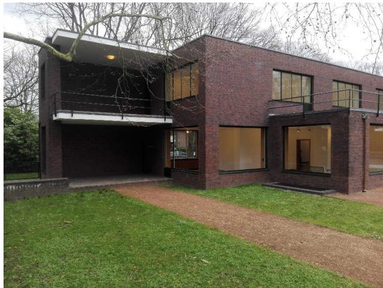
Figura 128 – Casa Lange exterior, 2019.
