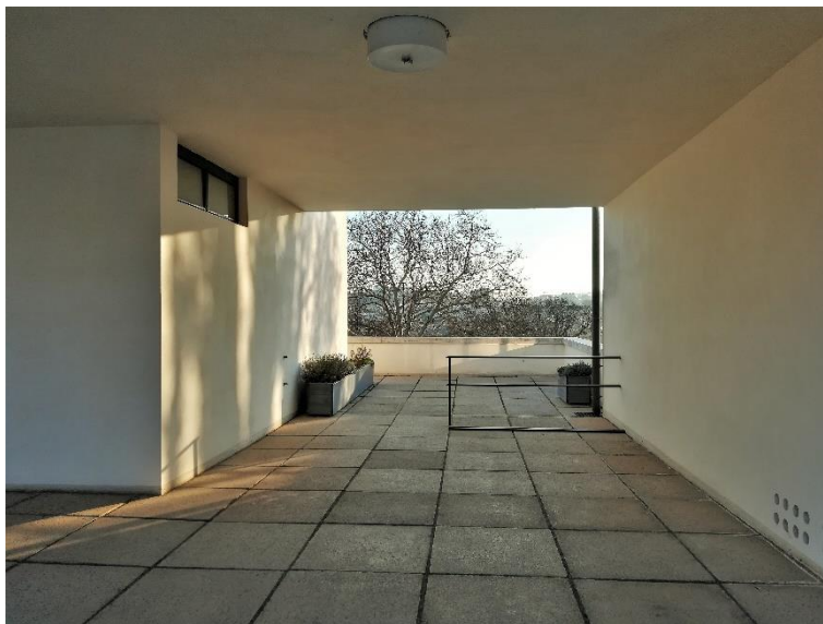
Figura 139 – Terraço exterior na zona da entrada principal da casa, 2019.
