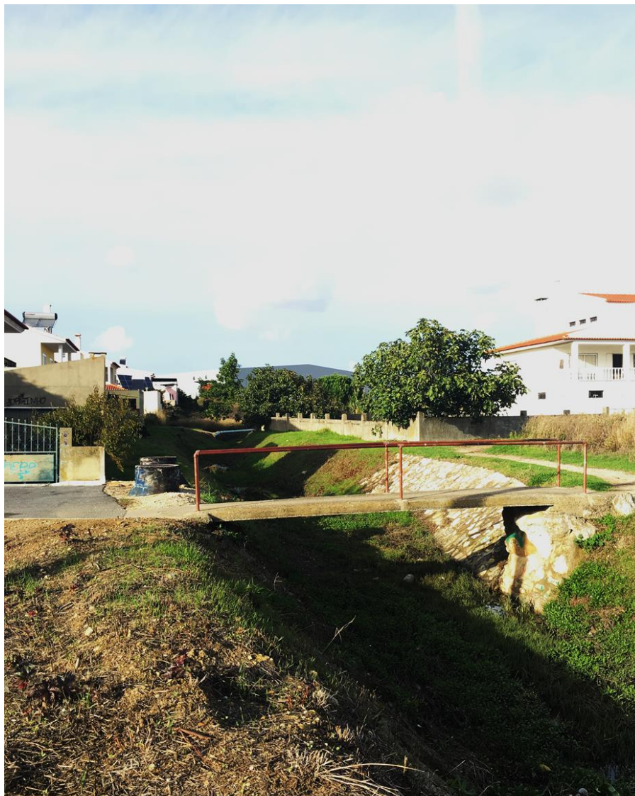
Figura 31 – Fotografia do terreno, Atravessamento sobre a ribeira
