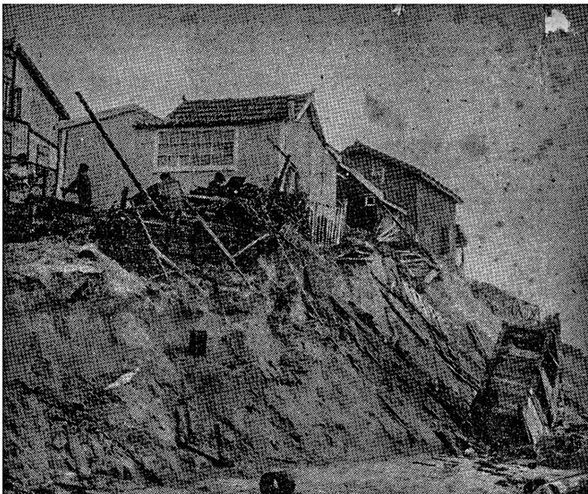
Figura 13- “Recorte de Jornal, destruição provocada pelo mar”, 1962 Habitação com tabuado à vista, típico das habitações vernaculares da Cova do Vapor.
