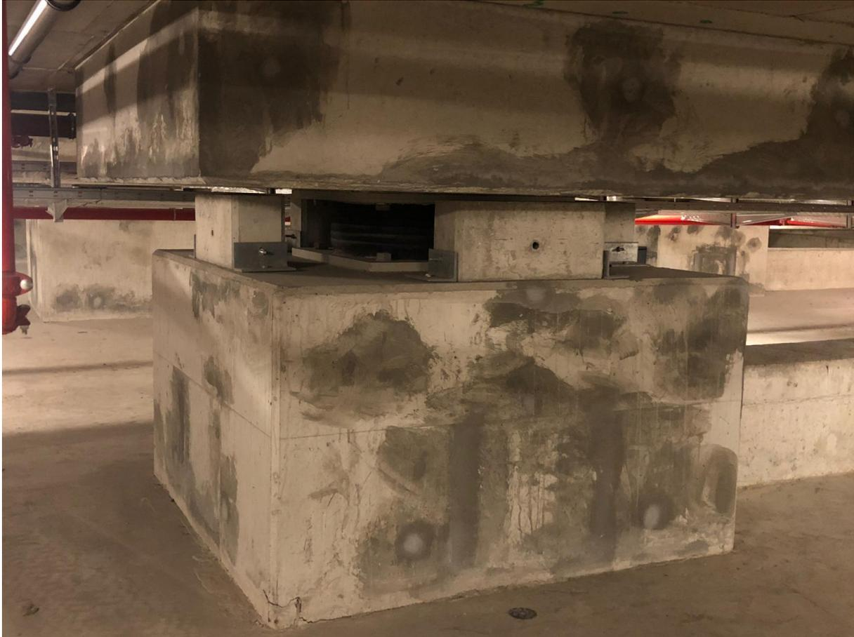
*Figura 43- Apoios de borracha de alto amortecimento; Fotografia do Autor; 12 de fevereiro de 2019*
