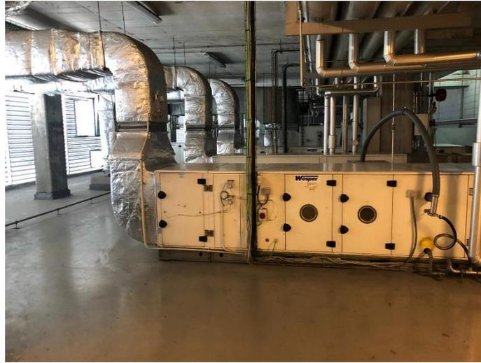
Figura 113- Refrigeração para os blocos operatórios, no piso superior; Fotografia do autor; Data: 12 de fevereiro de 2019
