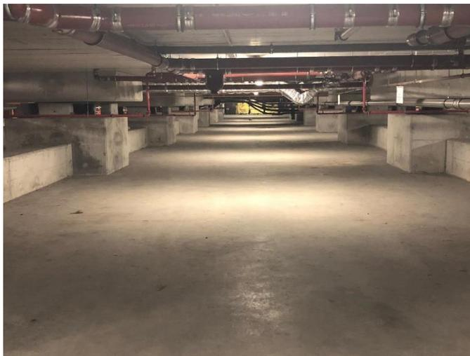
Figura 115- Zona de acesso aos apoios de borracha de alto amortecimento;
