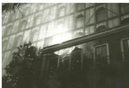
Figura 34 – Parte da fachada do Hotel Fontecruz Lisboa (2014) (à esquerda e no topo)
