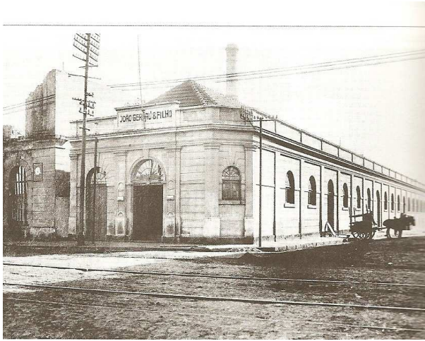
Imagem 10 – A antiga fábrica de pregos, na Rua Garibaldi, em 1948 Fonte: Memórias de Aço – Germano Gerdau Johannpeter. 2007
