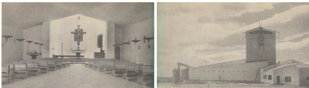
Figura 112 - Igreja de San Vincenzo de Paoli, La Martella (Ludovico Quaroni, 1951-54) acessível em PORTAS, Nuno – Arquitectura Religiosa Moderna em Portugal. Arquitectura . n.º 60, (Outubro de 1957). p. 20-34
