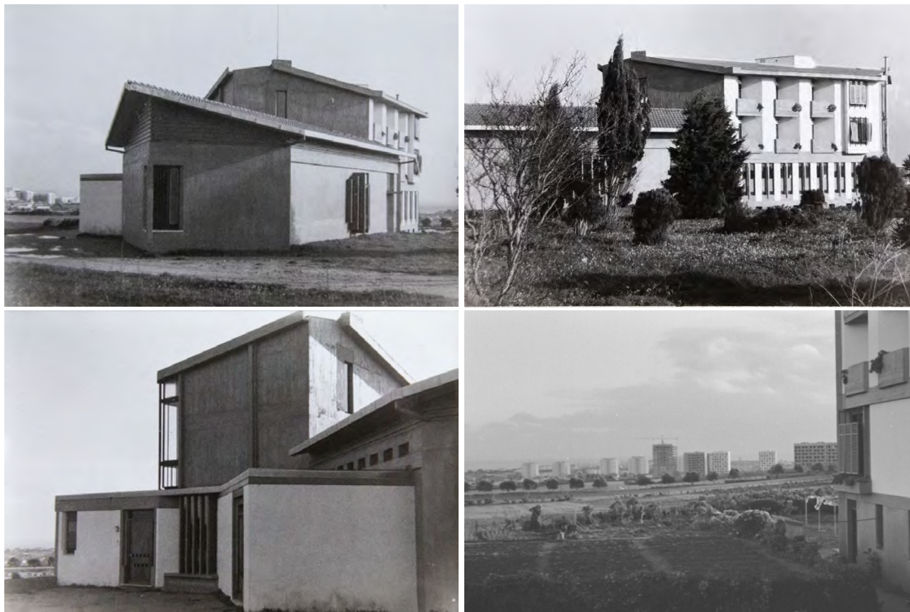
Figura 130 - Fotografias do mosteiro após a interrupção da construção acessíveis no Arquivo Pessoal do Arquitecto Nuno Teotónio Pereira, Forte de Sacavém, SIPA [Negativos da obra feita - PT NTP FOTO 12156 – 12186] e [fotografias da obra feita 1978 (1ª fase) - PT NTP FOTO 12015 - 12020]
