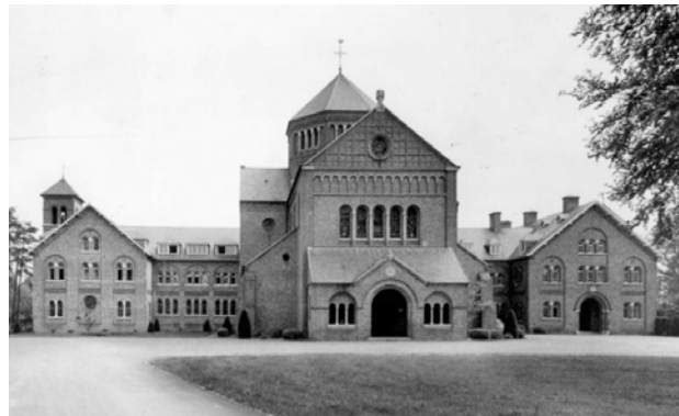
Figura 44 - Mosteiro de Notre Dame de Béthanie na sua versão final, cuja primeira pedra foi benzida “no local onde mais tarde seria construída a igreja”, no dia 21 de Março de 1924 ( Histoire des Moniales Bénédictines de la Reine des Apôtres: Des Anées Laborieuses 1930-1945 . Rixensart: Editions du Centre «Le Chemin», 2006. Tomo IV. p. 79;). Postal Ilustrado. In delcampe.net
