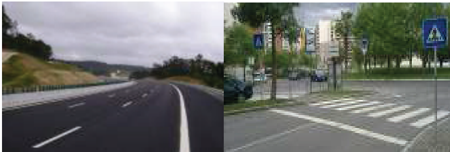
Figura 6 – SH na rede viária portuguesa: pintura longitudinal e transversal, respetivamente
