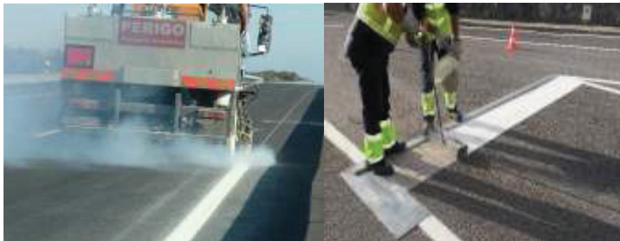
Figura 17 – Pintura de SH na rede viária portuguesa: pintura longitudinal e transversal, respetivamente
