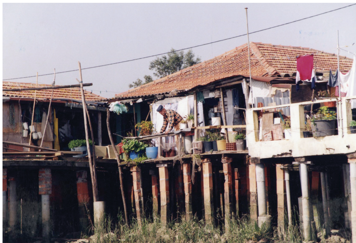
Fig. 12 | Habitação de Avieiros sobre pilares de tijolo com reboco
