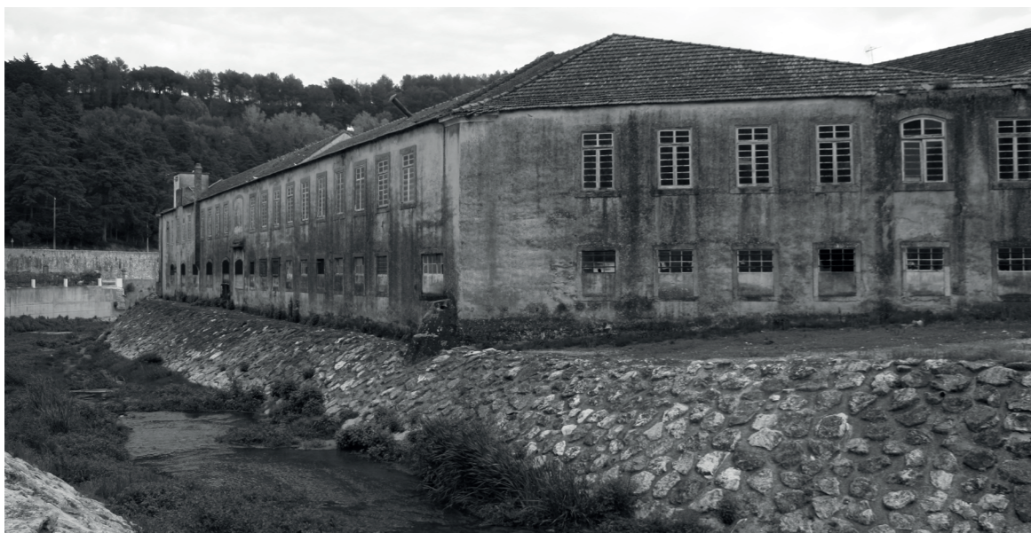
Figura 25. Fotografia Fachada Norte (do autor).
