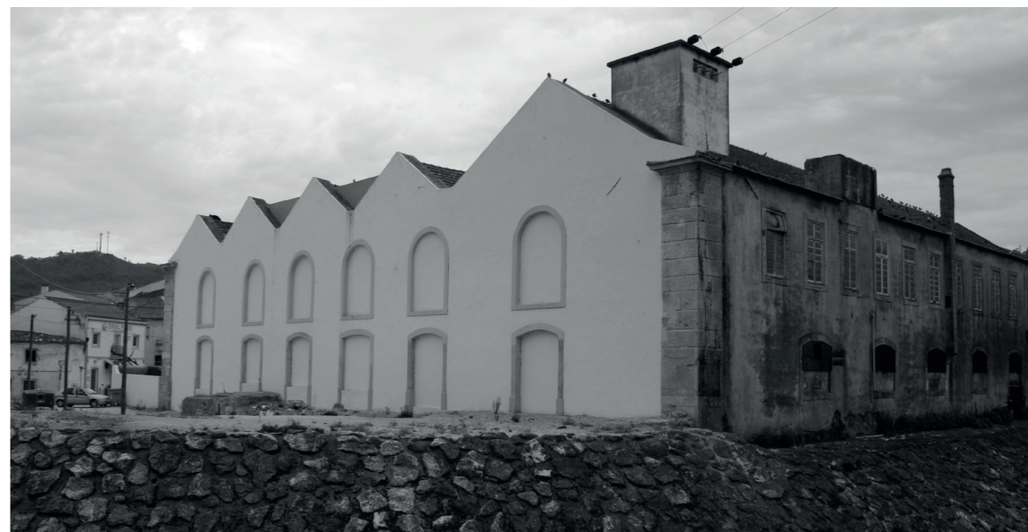
Figura 27. Fotografia Fachada Este (do autor).
