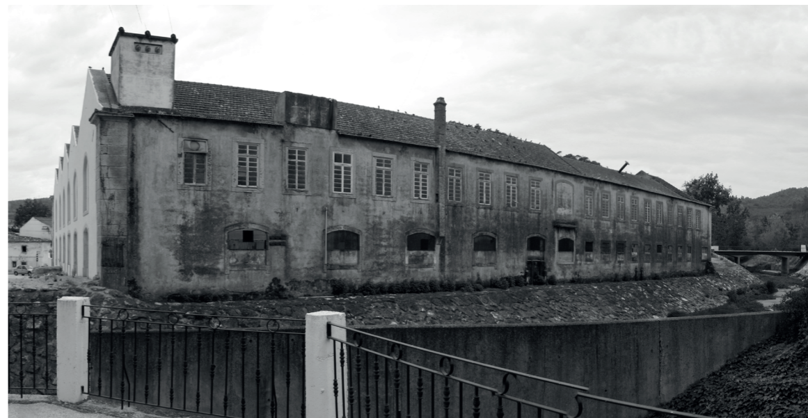
Figura 26. Fotografia Fachada Norte (do autor).
