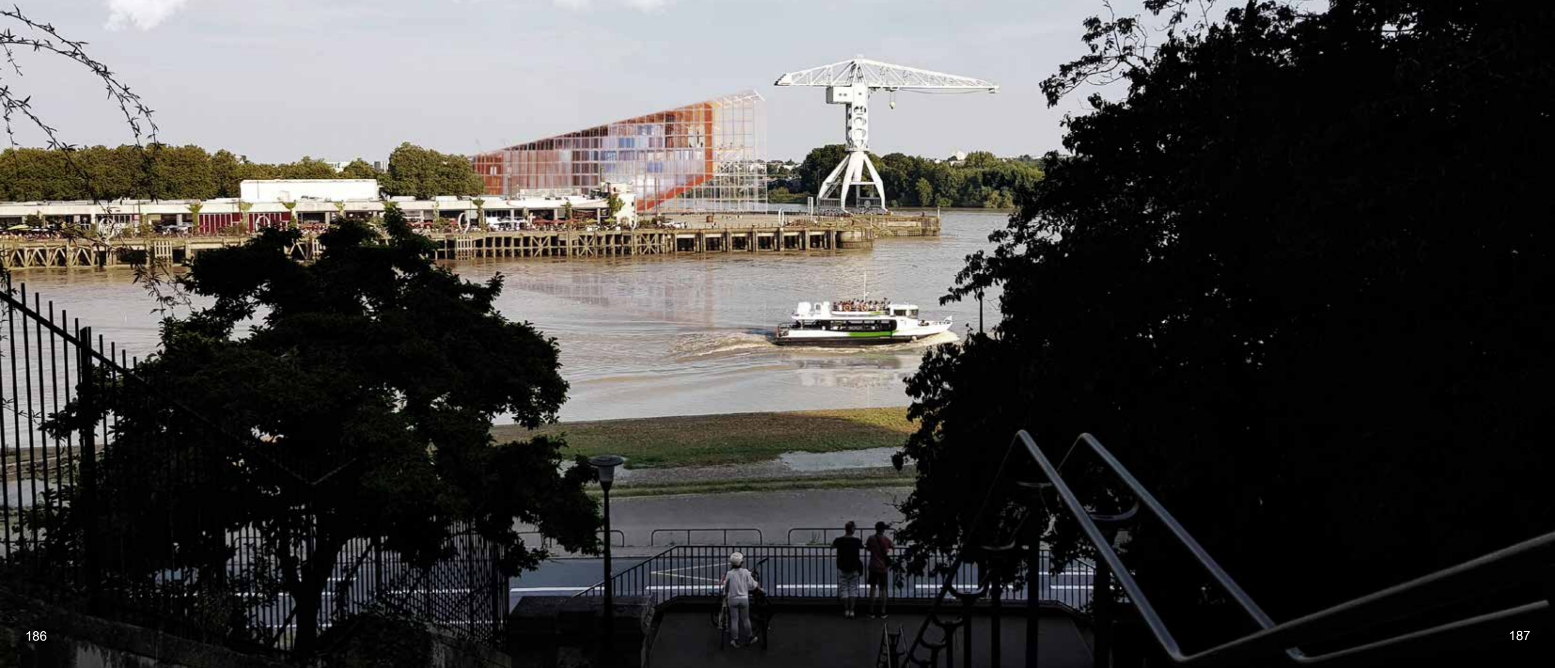
IMAGEM 128 - Render exterior durante o dia do projeto "Phare en ville", estrutura de grandes dimensões mas ao mesmo tempo leve e transparente. Podemos ver a relação entre a grua "Titan" e o edifício.
