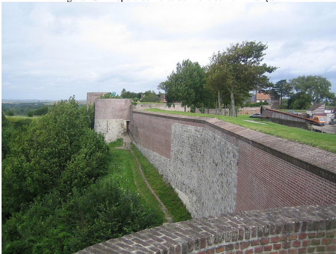
Figura 4.9 – Reparo do Forte de Montreuil em França
