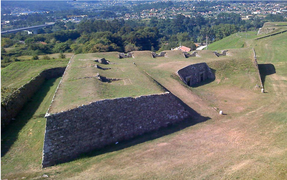
Figura 4.7 – Revelim da Praça-Forte de Valença
