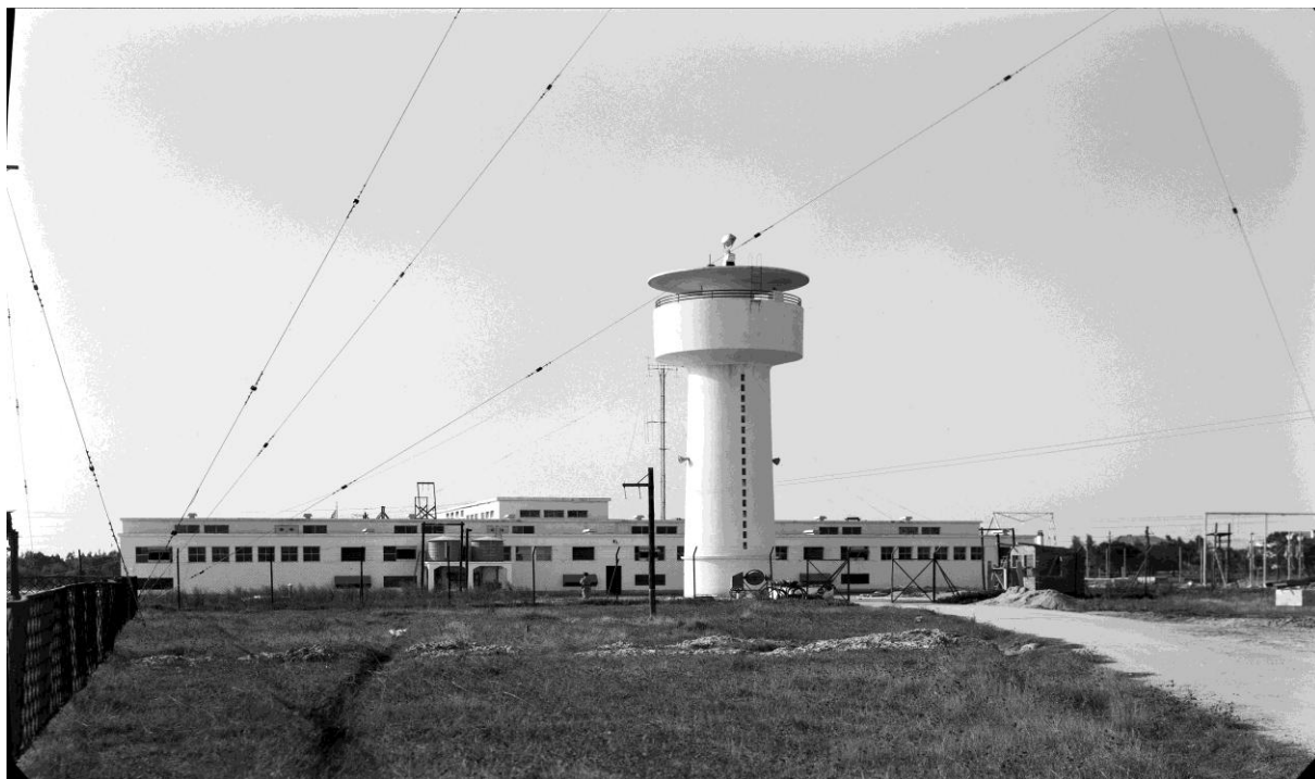
Vista da torre da água e traseiras do edifício principal. Fotografia s/d, CFT003 072350.ic
