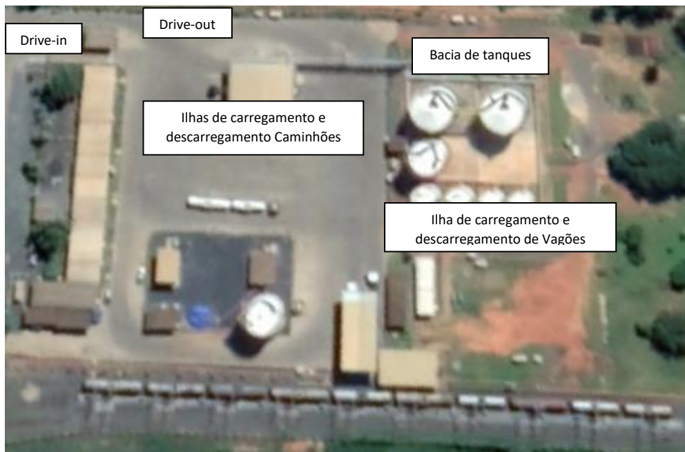
Figura 4 - Vista de Satélite do Terminal de Montes Claros – MG – Brasil
