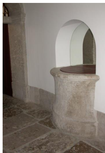
Fig. 114 – Poços de cantaria existente nos átrios. O da esquerda, na rua de São Julião 24-32. O da direita na rua Nova do Carvalho 43-51.
