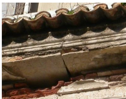
Fig. 70 – Cimalha arruinada de um prédio da Baixa, onde estão visíveis os diversos componentes.
