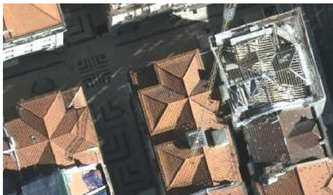
Fig. 108 - Fotografia aérea de telhados com trapeirões, no cruzamento da rua Augusta com a rua de Santa Justa. Do lado direito vê-se o vigeamento de uma cobertura de três trapeirões, posto a descoberto. 224
