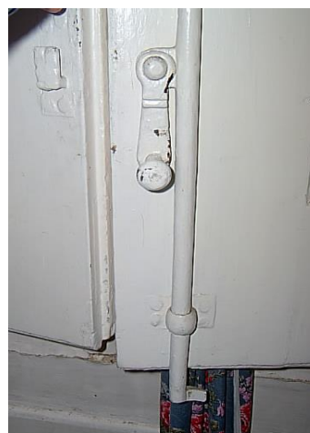
Fig. 73 – Tranca de espanholeta. 190
