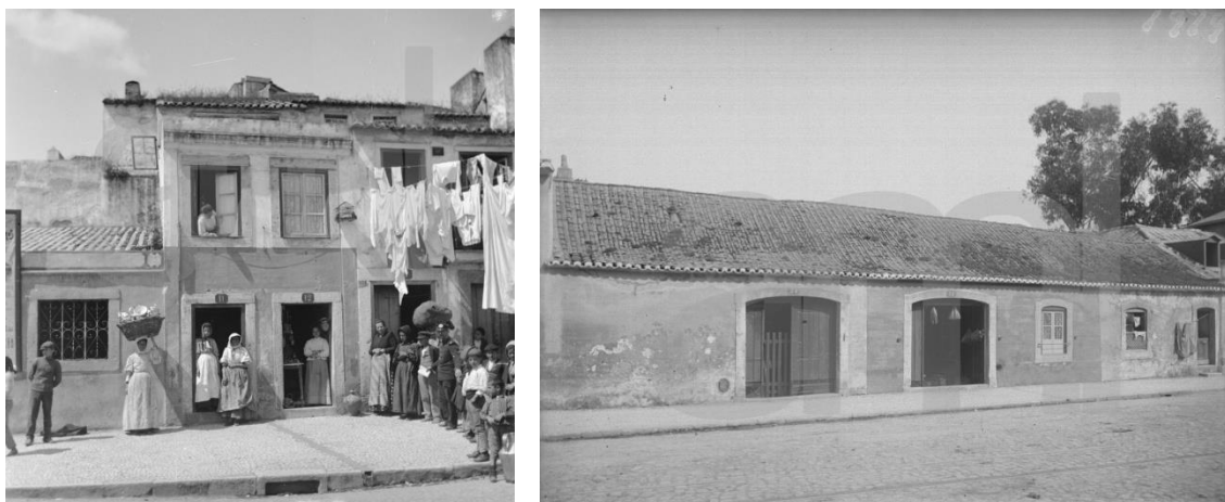
Fig. 30 – Prédios de um e dois pisos, no largo de Santa Bárbara e na rua de Arroios, já entre os anos 1898 e 1908 82 .
