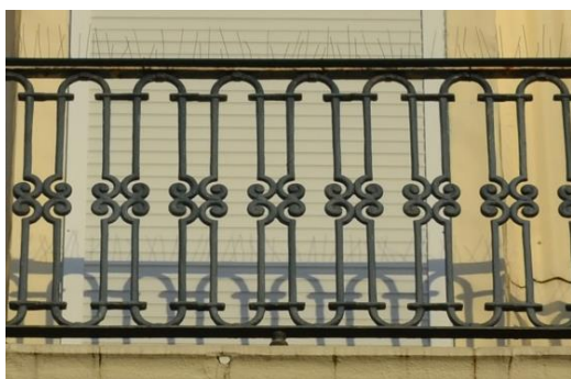
Fig. 171 – Guarda de varanda em ferro fundido. Fig. 172 – Grelha de bandeira de porta de rua.
