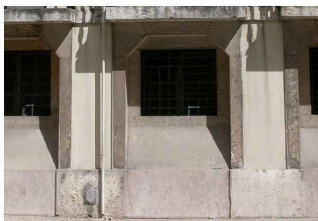
Fig. 57 – Vãos do piso térreo das dependências da igreja de São Julião.
