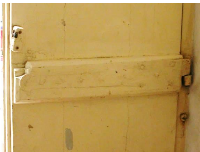
Fig. 76 - Pormenores da face interior da porta da rua, com travessas, taleiras e dobradiças de cachimbo. Rua dos Correeiros 177-179.
