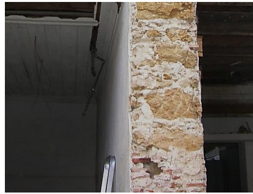
Fig. 65 – Rua Ivens 21-33. Paredes de empena.
