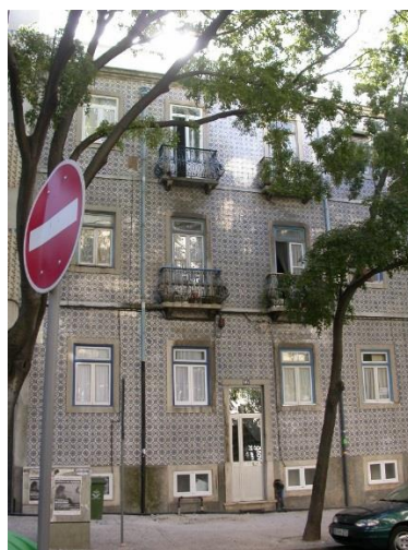
Fig. 180 – Fachada com 4 MVV e porta ao centro, na Rua Passos Manuel 110.
