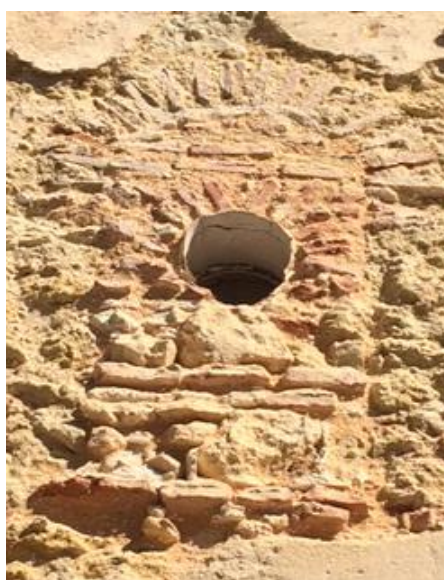
Fig. 38 – Disposição do lambaz no arco de ressalva para a construção do óculo de arejamento da caixa de escada, na fachada do prédio do largo de Santa Bárbara 11.
