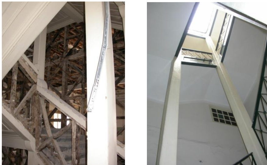
Fig. 109 – Caixas de escadas assentes em prumos de madeira. À esquerda, na rua Ivens 27-33. À direita, na rua do Crucifixo 48-56.
