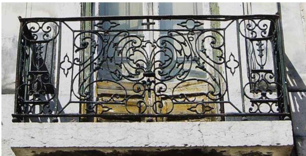
Fig. 102 – Grade de ferro forjado em barra, com pequenos elementos de ferro fundido incorporados. Rua da Madalena 163.
