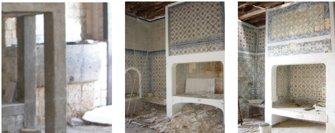
Fig. 117 – Vários tipos de chaminés de cozinha. À esquerda no edifício da rua Ivens 27-33 vendo-se ao fundo um depósito de água em cantaria. Ao centro e à direita, na rua da Madalena 211-217.
