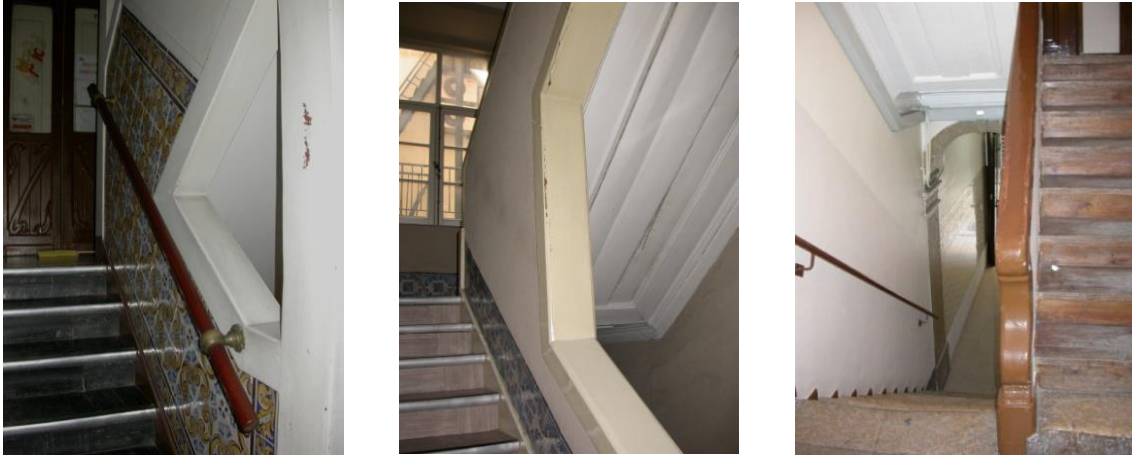
Fig. 82 – Escadas de dois lanços por piso, sem bomba. À esquerda, assente num prumo, na Rua Augusta, 264-270. Ao centro, em parede de frontal recortado, na rua de São Julião, 136. À direita, com supressão da parede, na rua dos Correeiros 199-205.
