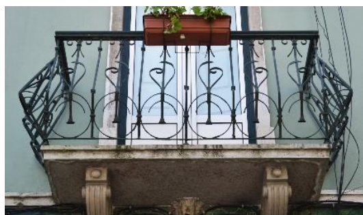
Fig. 234 – Guarda-corpo quinado.
