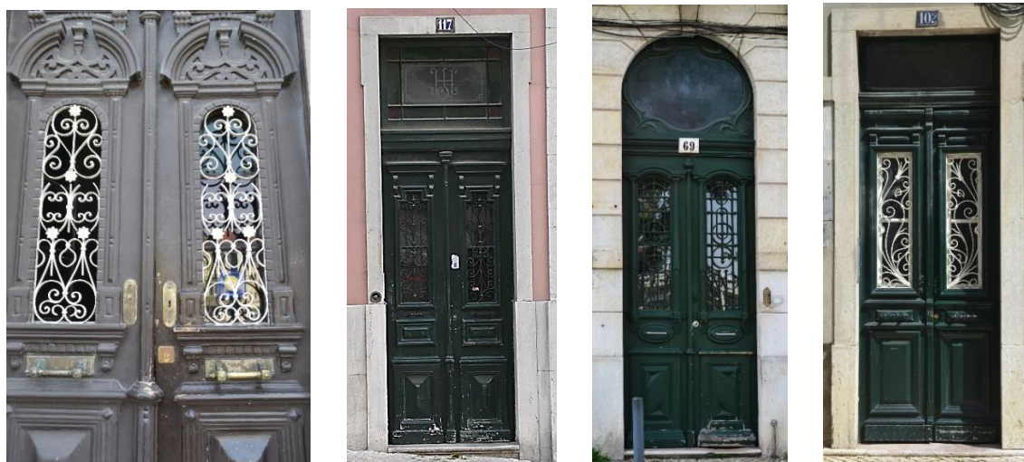
Fig. 235 – Portas de rua em prédios edificadas nas duas primeiras décadas do século vinte. 493
