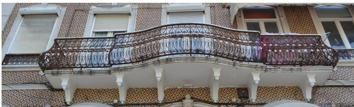
Fig. 232 – Guarda-corpo bojudo ou convexo.
