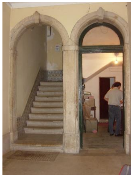
Fig. 81 – Arcos duplos em cantaria lavrada. À esquerda na rua de São Julião 78-84 e, à direita, na rua dos Douradores 16-26.
