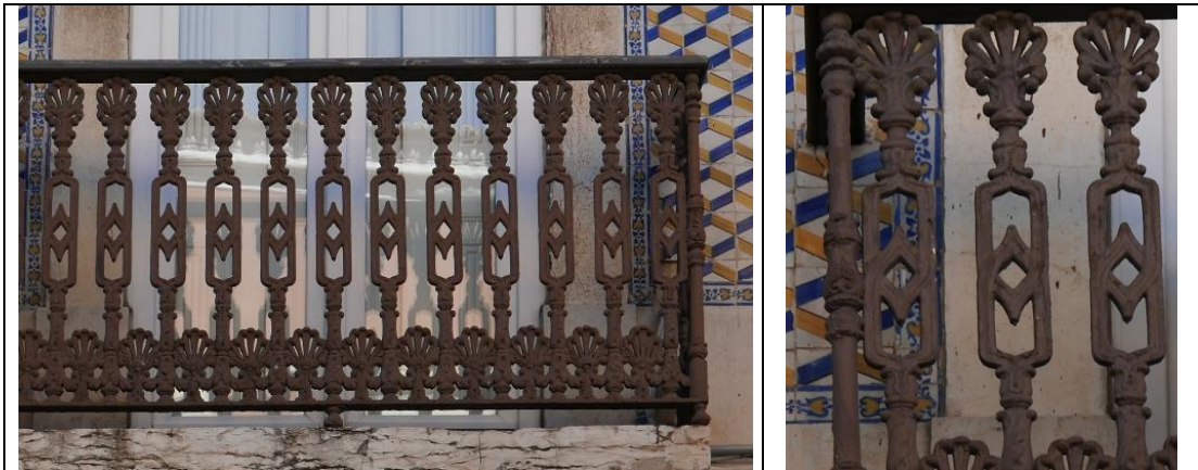
Fig. 19. Data da edificação: 1861 – Largo do Conde Barão 15-21.
