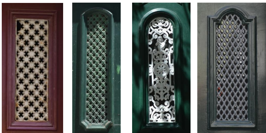
Fig. 188 – Grades de postigo, em ferro fundido, da década de 1880.
