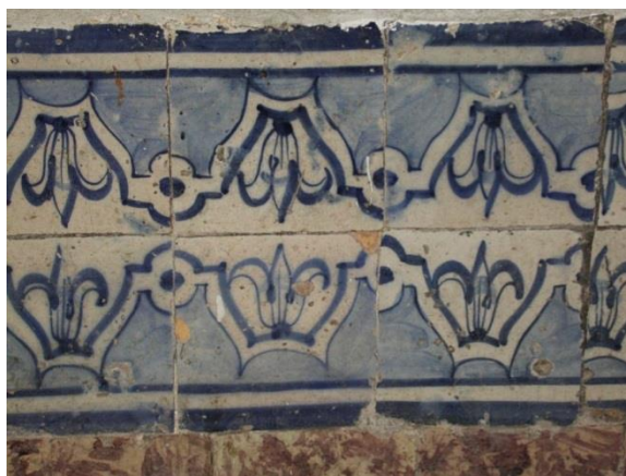
Fig. 90 - Azulejos de padrão flor-de-lis sobre rodapé de azulejos de pedra-torta, no lambril de uma escada, na rua da Vitória 42-48.
