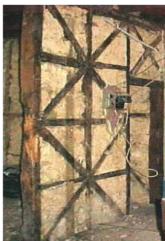
Fig. 66 – Parede frontal, paralela à fachada.
