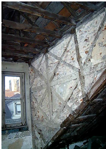
Fig. 71 – Elementos estruturais de uma janela de trapeira, pombalina, na rua da Prata 53-65.
