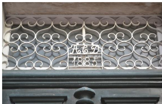
Fig. 171 – Guarda de varanda em ferro fundido. Fig. 172 – Grelha de bandeira de porta de rua.
