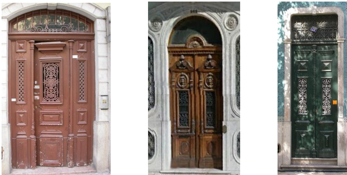
Fig. 189 – À esquerda, porta de 1891, na rua Dona Estefânia. Ao centro, porta de 1891 na avenida da Liberdade. À direita, porta de 1896, na rua José Estêvão.
