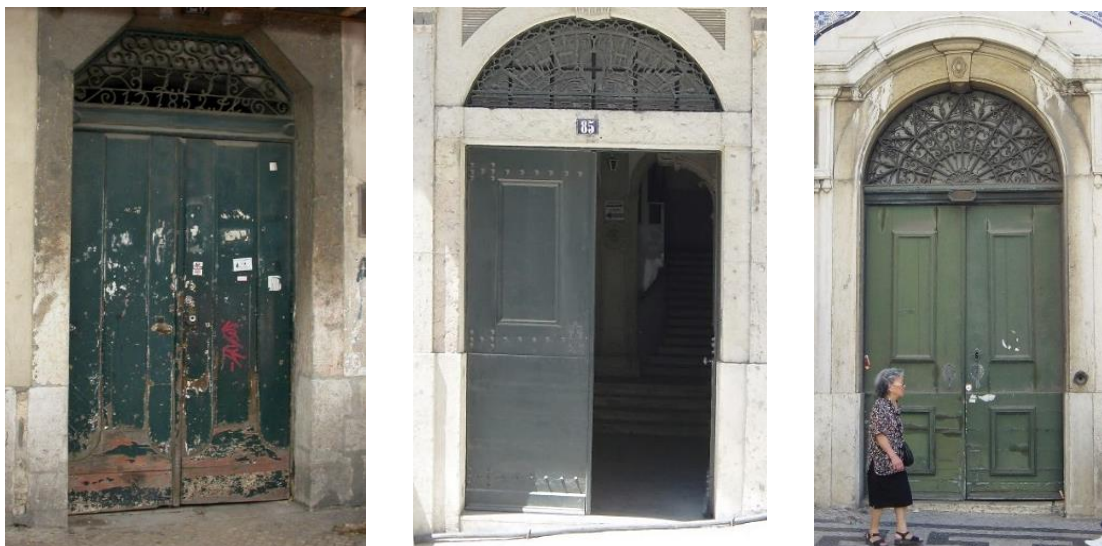
Fig. 160 – Da esquerda para a direita, portas de edifícios de meados do século XIX, situados na rua dos Correiros 120, rua da Madalena 85, e rua dos Fanqueiros 136.
