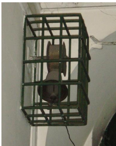
Fig. 84 - Sineta existente num átrio, posteriormente protegida por uma caixa gradeada. Rua dos Fanqueiros 182-200.
