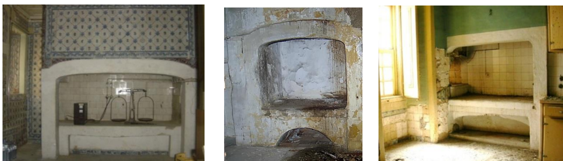
Fig. 86 – À esquerda 208 e ao centro chaminés de verga curva, e à direita, chaminé de verga reta com curvatura nos ângulos.
