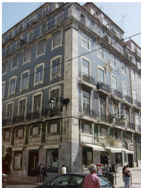
Fig. 99 – Varandas nas duas fachadas, não só no primeiro andar, mas também no segundo, em prédio da década de 1790, localizado na rua da Prata 150-160, a tornejear para a rua da Vitória.
