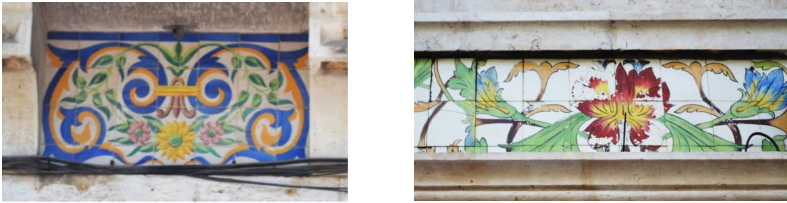
Fig. 228 – Azulejos aplicados sob varandas, presumivelmente produzidos na Fábrica de Louça de Sacavém. O da esquerda, no edifício da Avenida Duque de Ávila 63-65, com projeto de 1910, e o da direita, na avenida Duque de Ávila 15-19, projetado em 1914.
