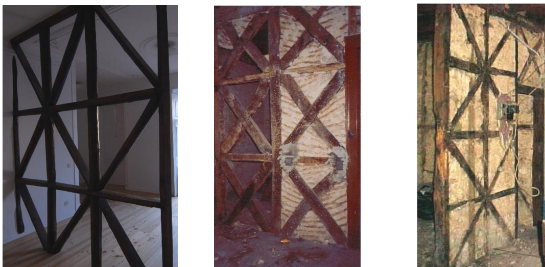
Fig. 199 – Na foto da esquerda vê-se um frontal de madeira com altura de uma cruz e meia, datado de 1885, as fotos do centro e da direita representam a estrutura pombalina de uma parede travessa e de parede frontal, respetivamente, de três e de duas cruzes. 401
