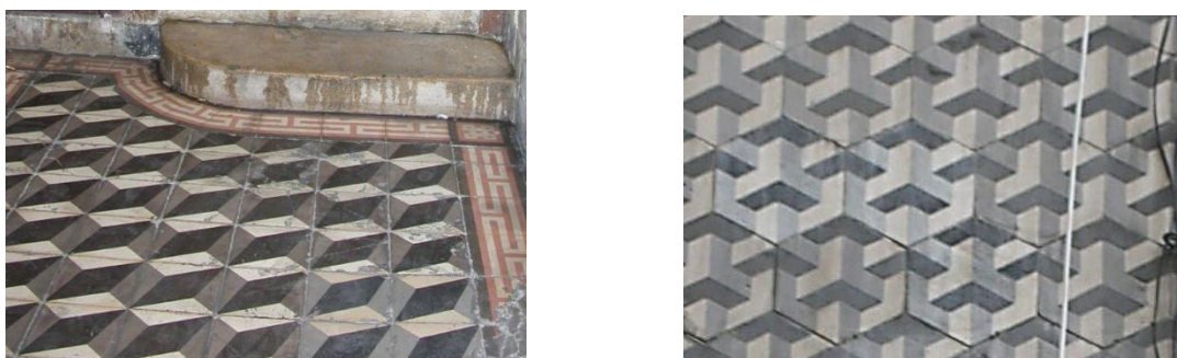
Fig. 167 – Mosaico de pasta de cimento na Rua Primeiro de Dezembro 10-14, e na rua dos Sapateiros 64-70.
