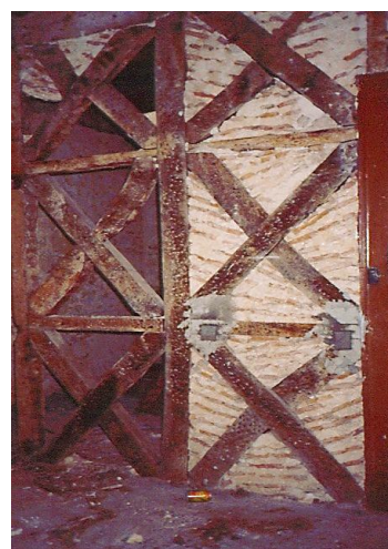
Fig. 67 – Parede perpendicular à fachada.
