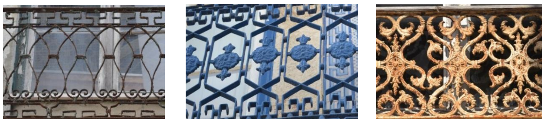
Fig. 153 – Da esquerda para a direita, gradeamentos de varandas na travessa. Nova de S. Domingos 50, datado de 1848, na Rua das Trinas 67-73, datado de 1852 e na rua do Possolo 41, edificado em 1851.
