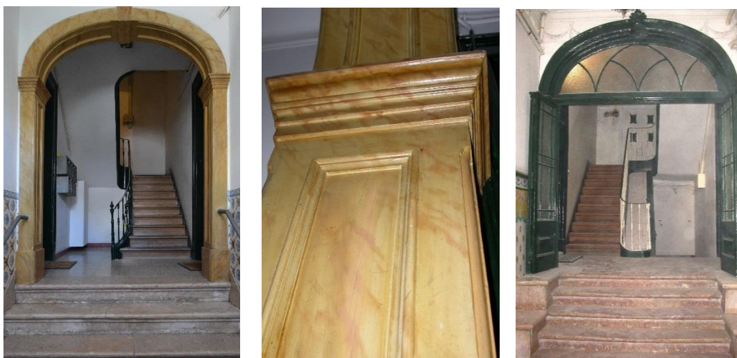
Fig. 190 – Arcos em madeira em átrios de prédios construídos nas décadas de 1880 e 1990. No da imagem à esquerda e ao centro, a pintura marmoreada a tinta de óleo sobre madeira, é a original.
