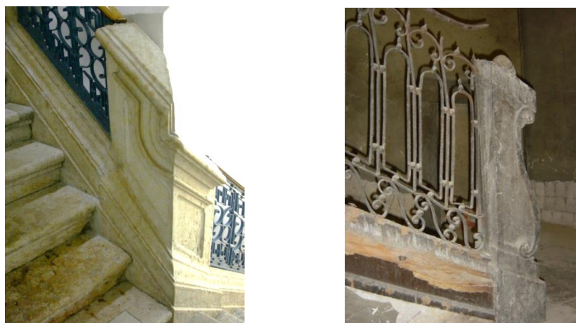
Fig.113 – Peças em cantaria, de fixação das guardas de escada. À esquerda, na rua dos Sapateiros 193-201, da década de 1790. À direita, na rua da Madalena 129-137, presumivelmente, dos anos 1780.
