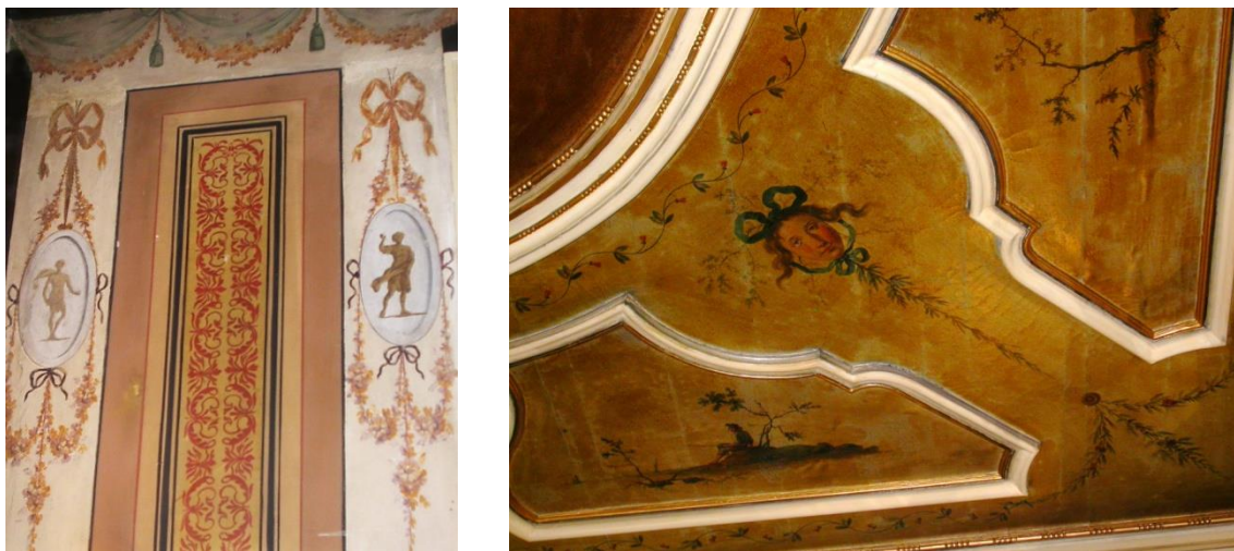
Fig. 127 - Pinturas neoclássicas, à esquerda em paredes sobre estuque, e à direita, no teto, sobre tela, na rua da Prata 221-231.
