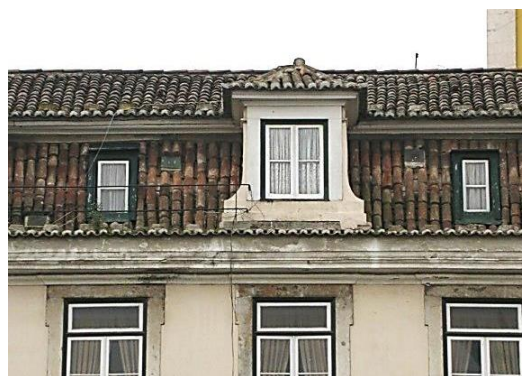
Fig. 69 – Telhado de águas sobrepostas.
