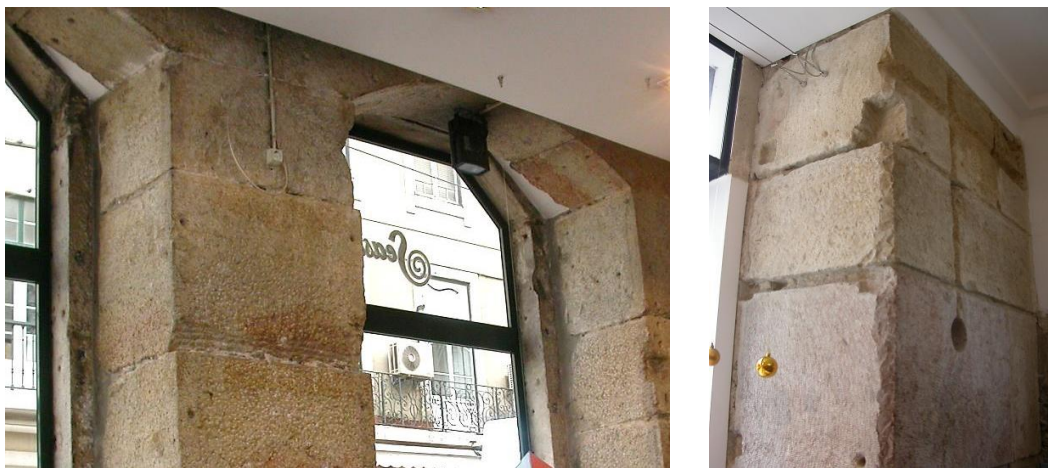
Fig. 61 – Paredes em perpianho na loja do edifício da praça da Figueira que torneja para a rua dos Fanqueiros 283-291.
