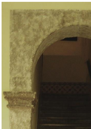
Fig. 80 – Pormenor de arco simples em cantaria, da década de 1770. Rua dos Douradores 128-134; Rua da Assunção 9-13.
