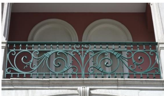
Fig. 233 – Guarda-corpo plano.
