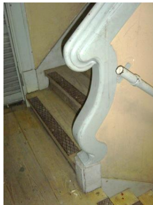
Fig. 83 – Remate de guarda-corpo.
