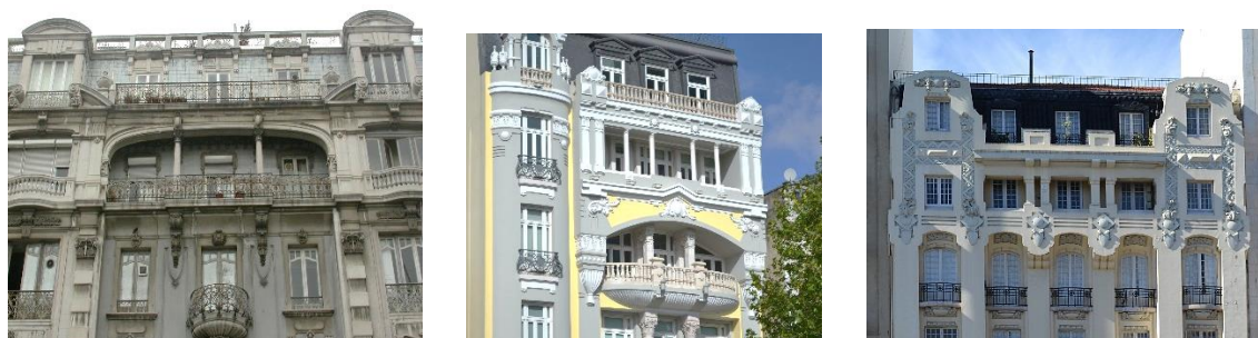
Fig. 212 – Terraços recuados relativamente à face exterior da fachada, na rua Braamcamp 84 e 86, avenida da República 15 e avenida da República 49.
