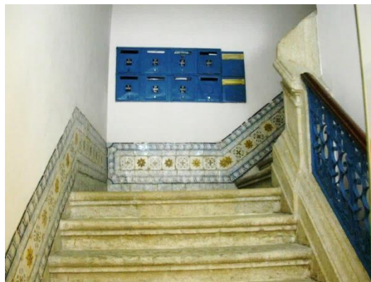
Fig. 112 – Escada de três lanços por piso, em cantaria. Rua dos Sapateiros 193-201; Rua de Santa Justa. Década de 1790.
