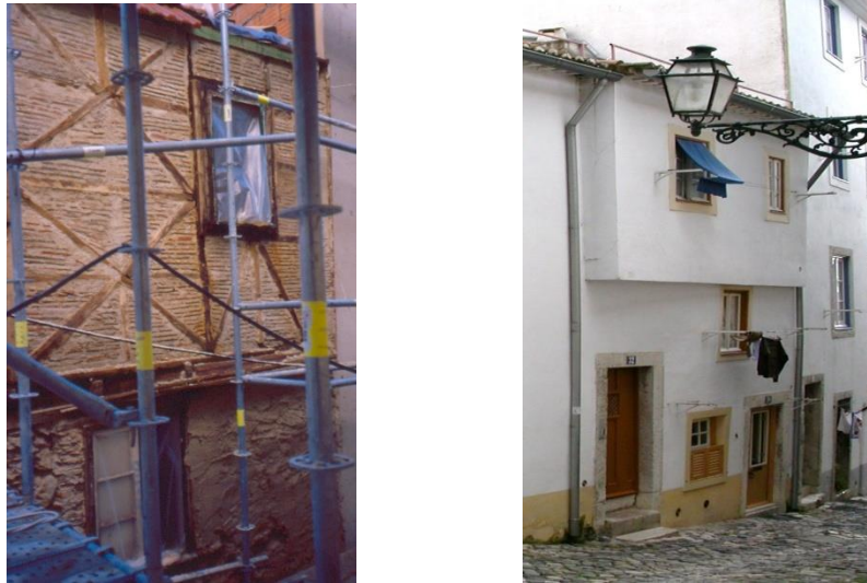
Fig. 1 – Paredes de fachada em ressalto, com frontal de madeira no piso superior, à esquerda durante das obras de 1998 e à direita no final da obra, na Rua do Espírito Santo ao Castelo, 30-34. 27
