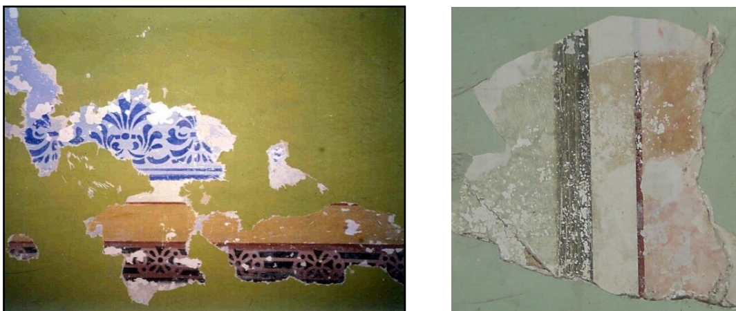
Fig. 166 – À esquerda vestígios de pintura à estampilha sobre estuque, e à direita, de pintura de faixas marmoreadas, ambas sob várias camadas de tinta.
