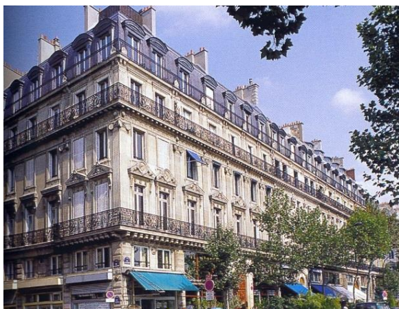
Fig. 185 – Edifício haussmanniano, Paris.
