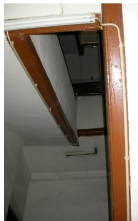
Fig. 110 – Escada de bomba estreita. Rua dos Sapateiros 155-163. Década de 1790.
