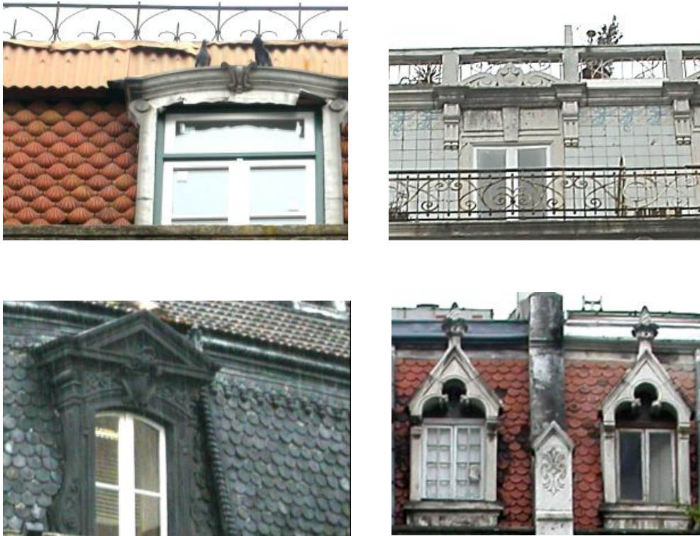
Fig. 200 – Materiais cerâmicos e folha de zinco em revestimento de mansardas.
