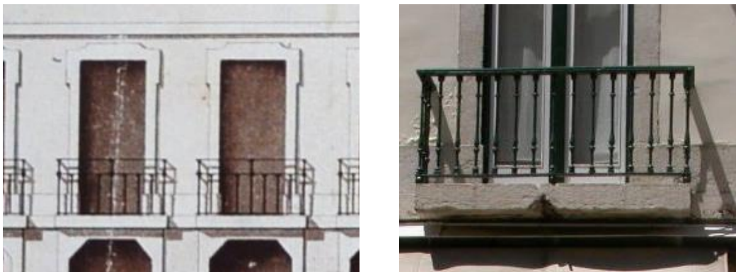
Fig. 79 - Desenho dos guarda-corpos de modelo 1, propostos para as ruas principais e a sua concretização nas varandas dos edifícios construídos entre 1760 e 1780, formados por balaústres de ferro.
