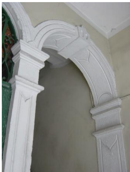
Fig. 81 – Arcos duplos em cantaria lavrada. À esquerda na rua de São Julião 78-84 e, à direita, na rua dos Douradores 16-26.
