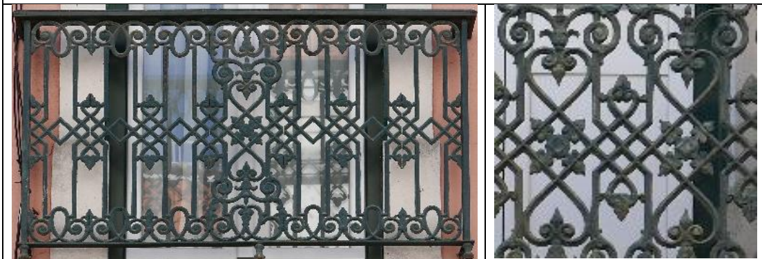
Fig. 20 Data da edificação. 1863 – Largo do Intendente 45. Data da edificação: 1890 - Rua Coelho da Rocha 23.
