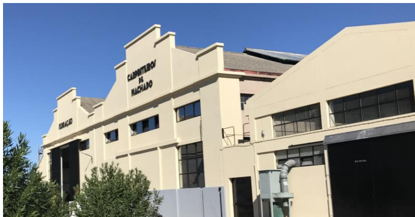
Figura 19. Fachada das oficinas de “Carpinteiros de Machado” e “Serração” da AA, SA
