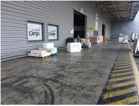
Figura 14 - Corredor exterior ao armazém de exportação.
