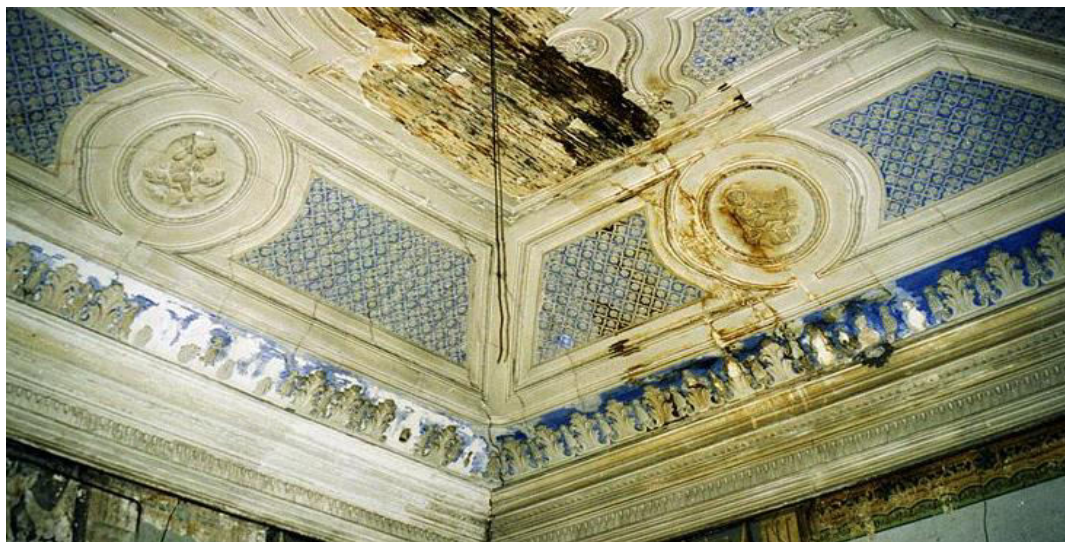
Figura 2 - Pormenor do estado de degradação do interior do Palácio Conde-Barão do Alvito. DGCP.
