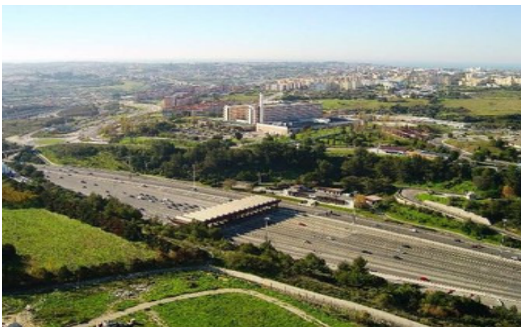
Ilustração 2 - Praça das portagens de acesso à Ponte 25 de Abril (Almada).
