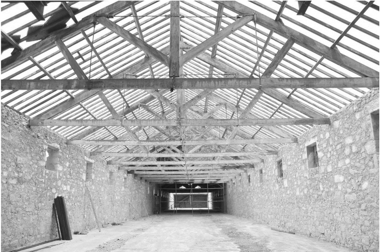
*Figura 4 – Vista que coloca em evidência as características estruturais amplas e flexibilidade espacial dos edifícios industriais. Interior da Real Companhia Vinícola em Matosinhos (Fotografia cedida gentilmente pelo Arquiteto Guilherme Vaz; Autoria: Desconhecida; Data: Desconhecida)*
