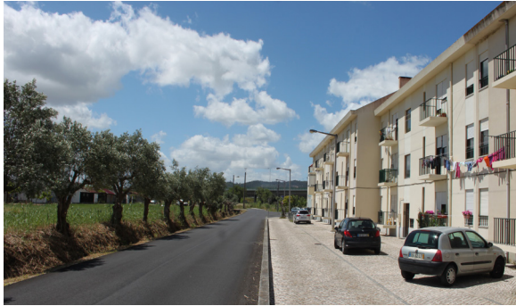
Estrada do Bairro, divide o Bairro Atral Cipan da zona intervencionada
