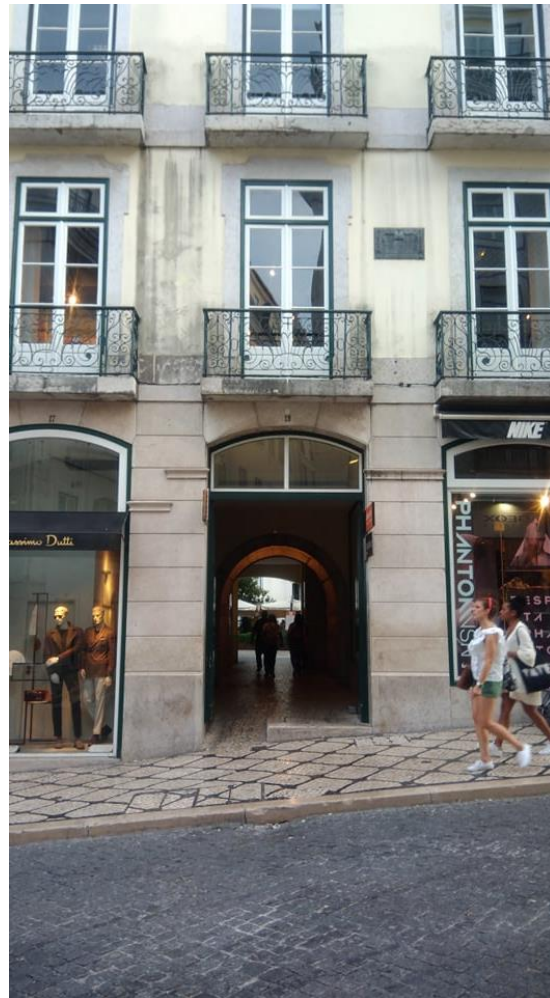
Imagem 25- Acesso ao interior do Pátio A pela rua Garrett
