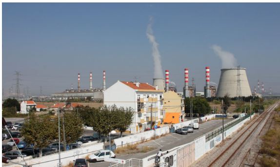
Rua da Estação com vista para a Central Termoelétrica
