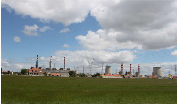
Central Termoelétrica do Ribatejo vista do terreno de intervenção
