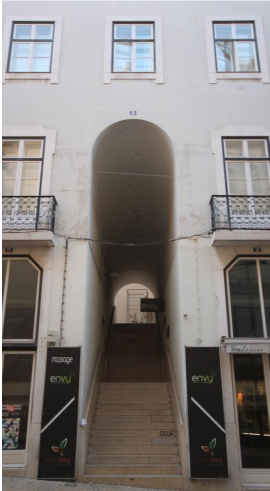
Imagem 33- Visibilidade para o interior do Pátio B a partir da Rua do Carmo
