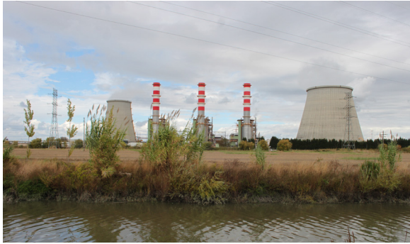
Vala do Carregado . Central Termoelétrica do Ribatejo
