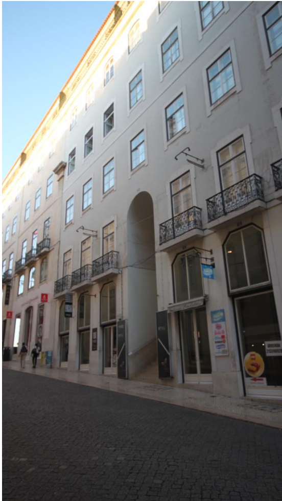
Imagem 28- Acesso ao Pátio B pela Rua do Carmo, destaque do acesso na fachada
