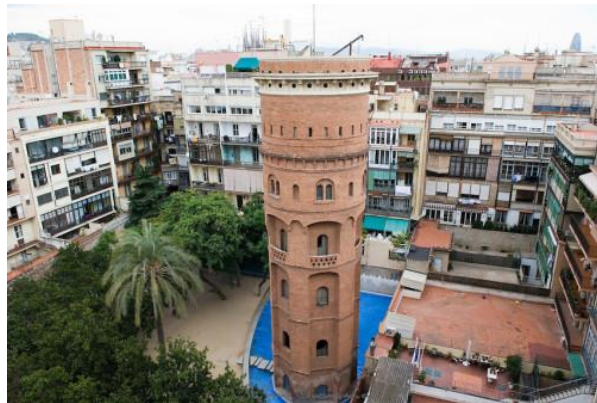
Imagem 8- Pátio interior da Torre de les Aigües após a renovação
