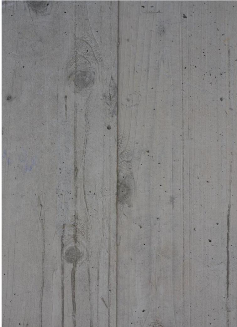
Figura 30: Materialidade dos novos edifícios, betão com cofragem de madeira.
