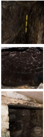
Figura 27: Sistema forno-lareira-chaminé da casa de habitação da Vila Conceição. Lareira com a entrada para o forno; cobertura abobadada do forno em pedra; interior da chaminé de “mãos-postas” (de baixo para cima).
