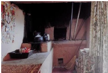
Figura 109: Lar construído em paredes de taipa, com a boca do forno ao fundo, na ilha da Terceira.
