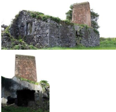
Figura 28: Construção terreira da Vila Conceição com o sistema forno-lareira-chaminé em pedra seca de cor vermelha.
