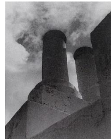
Figura 125: Chaminé de tubos emparelhados na Vila da Povoação, na ilha de São Miguel.
