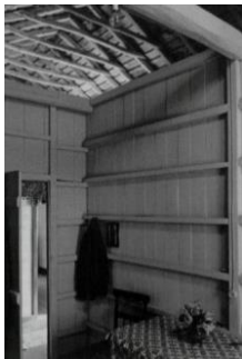
Figura 14: Interior da cobertura com as divisórias de madeira, na freguesia da Almagreira, na ilha de Santa Maria.
