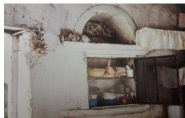
Figura 116: Copeira inserida na parede na freguesia das Lajes, na ilha das Flores.
