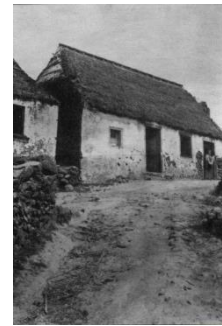
Figura 8: Casa de pedra caiada com cobertura de palha na freguesia dos Arrifes, na ilha de São Miguel.
