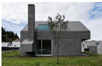
Figura 77: Pormenor do volume do forno, suspenso e adossado exteriormente à casa.
