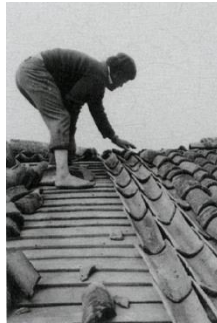
Figura 15: Reconstrução de cobertura com telha de meia-cana, na freguesia das Calhetas, na ilha de São Miguel.
