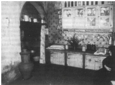
Figura 111: Cozinha térrea com o arco de chaminé que dá acesso aos poiais (de lume e de louça) e à boca do forno na freguesia da Achadinha, na ilha de São Miguel.
