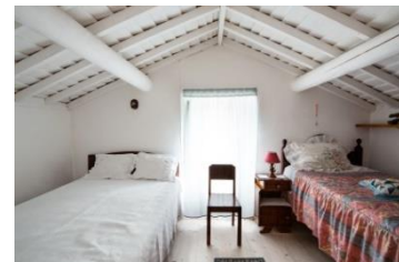
Figura 60: Estrutura da cobertura, com os barrotes e vigas de madeira do caso de estudo nº 5
