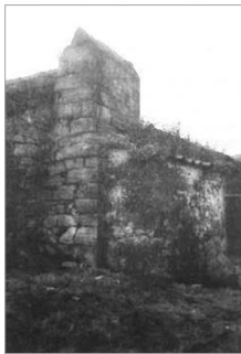
Figura 9: Casa com o sistema forno-lareira-chaminé exterior, na freguesia das Sete Cidades, na ilha de São Miguel.
