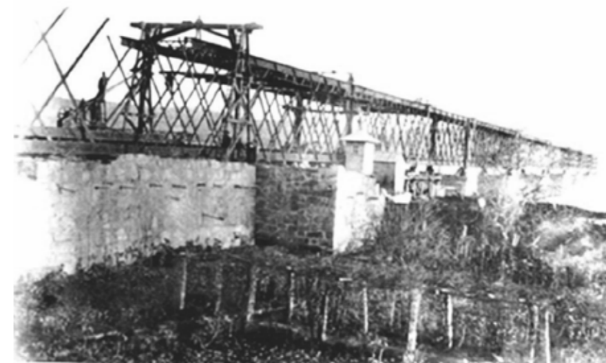
Fig.4 | Ponte Eiffel em construção
