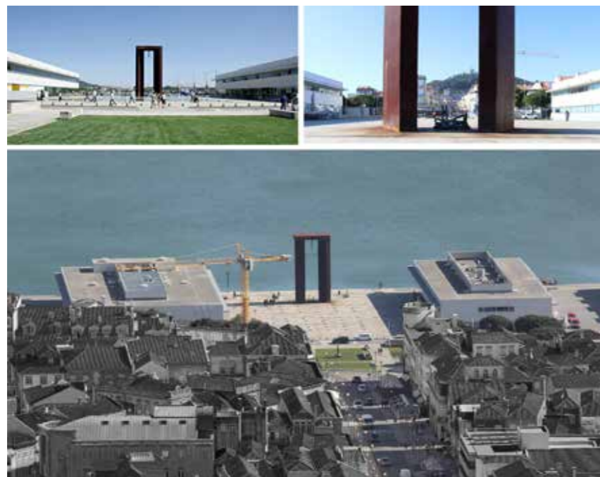
Fig.25 | Edifícios Administrativos, pelo Arquitecto Fernando Távora
