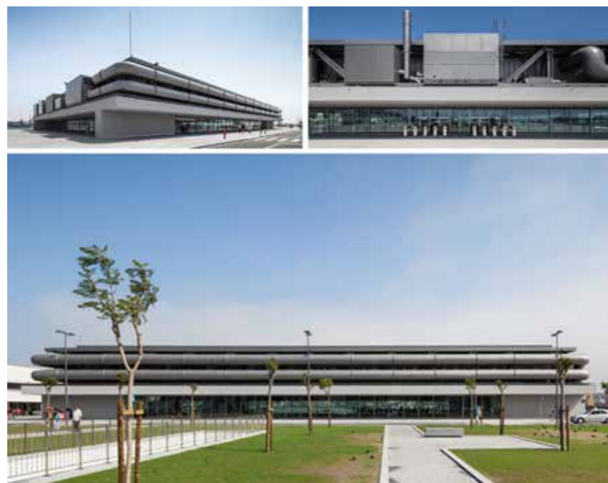
Fig.27 | Centro Cultural de Viana do Castelo pelo Arquiteto Eduardo Souto Moura
