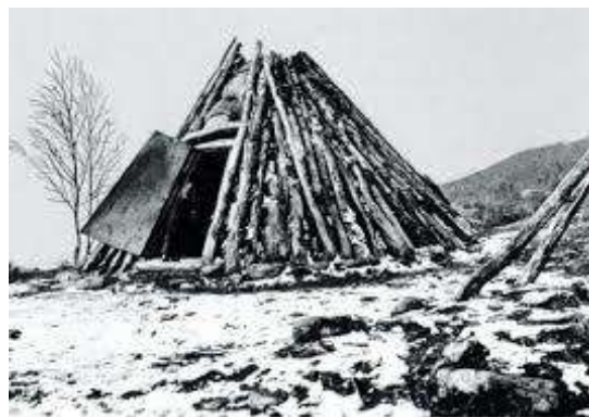
Figura 6 – Cabana, coberta com troncos. (DÍAZ, Gonzalo Pardo - Cuerpo y casa : hacia el espacio doméstico contemporáneo desde las transformaciones de la cocina y el cuarto de baño . p. 3.).
