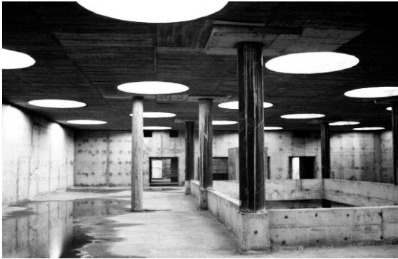
Figura 40: Obra em construção
