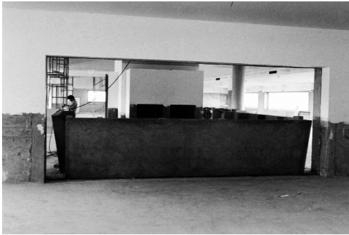
Figura 43: Recepção em construção
