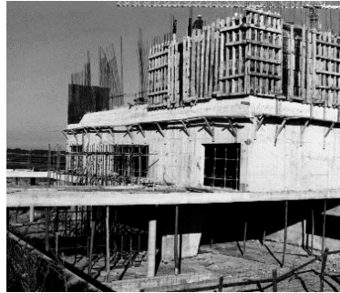
Figura 34: Obra em construção 1
