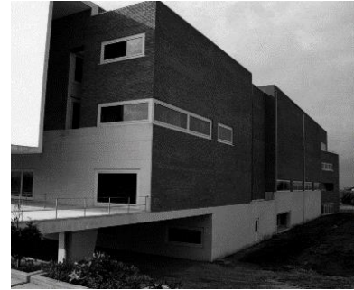
Figura 35: Obra em construção 2
