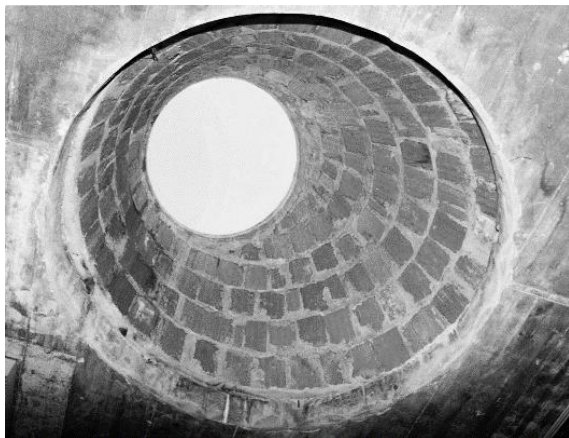
Figura 46: Lanternin em construção
