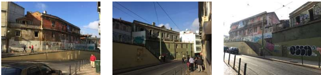
Imagem 1 | Vista do complexo edificado a partir da Rua Angelina Vidal. (Mendes, 2017)
