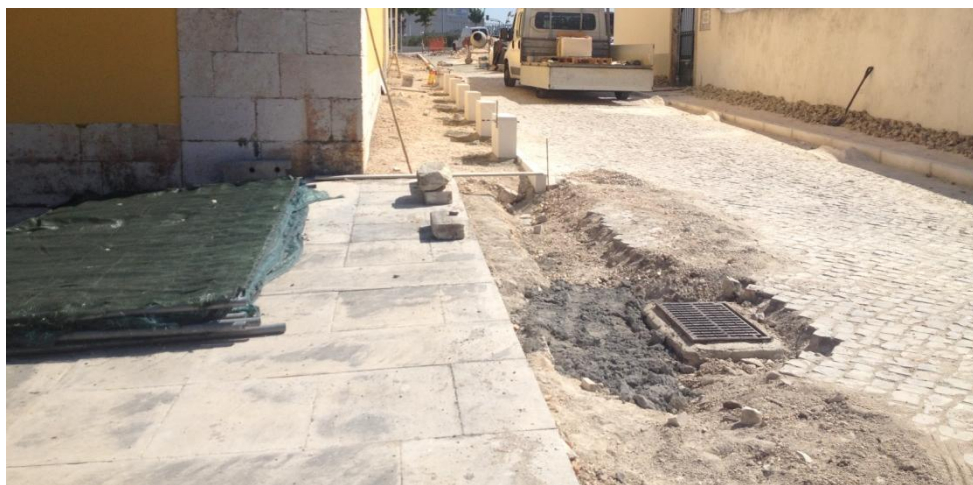
Imagem 55 –Elaboração dos trabalhos da rampa de acesso à igreja ( Arqt. a Barbara Delgado Martins , 2007)
