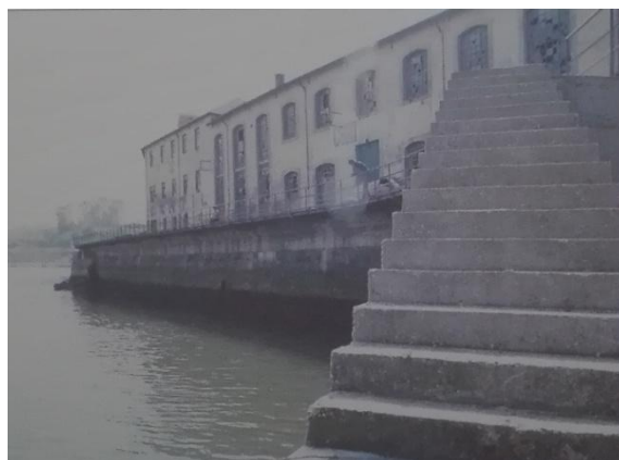
Imagem 37 – Exemplo de más acessibilidades, uma escada condiciona o acesso. (Brandão, 2008, p.149)
