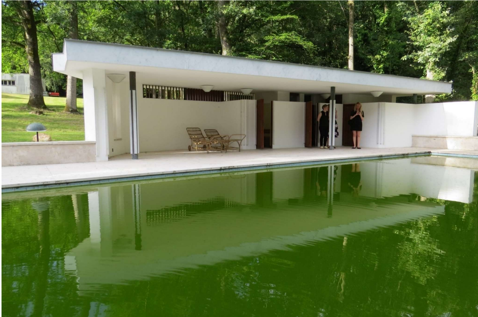
Maison Louis Carré / Piscina e edifício de apoio. (Fonte: fotografias, Madeira da Silva, T.).
