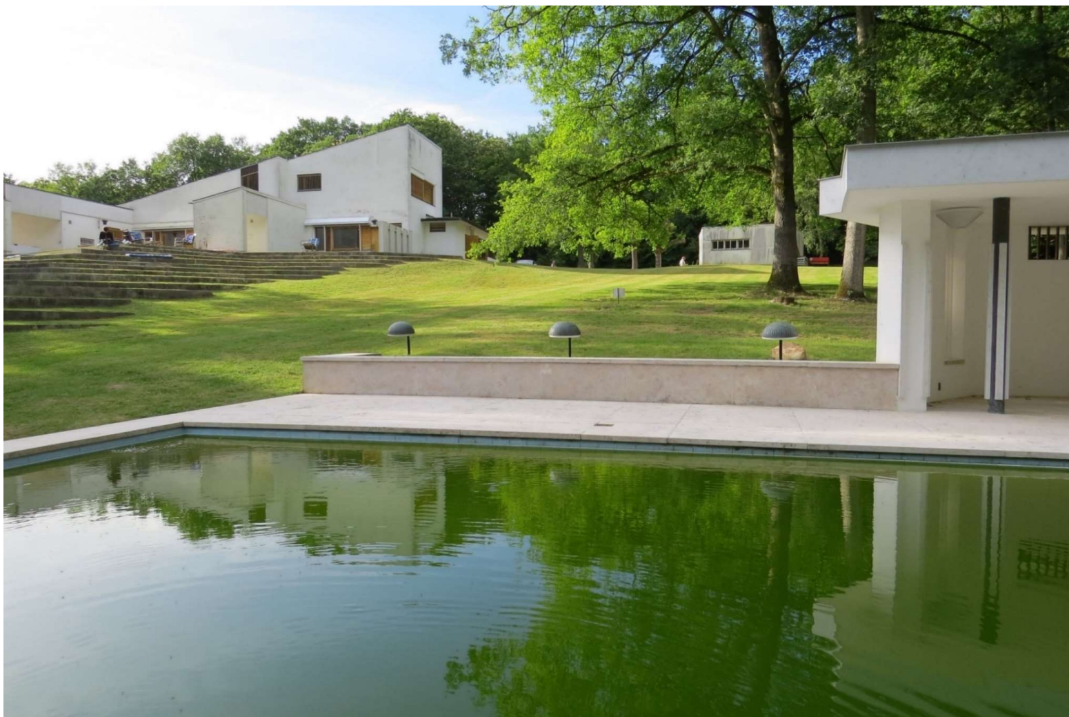
Maison Louis Carré / Vista de conjunto. (Fonte: fotografias, Madeira da Silva, T.).
