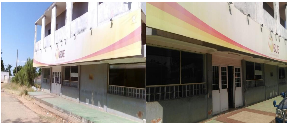
Figura C2. Parte externa das Instalações do Balção Único do Empreendedor no Moxico.
