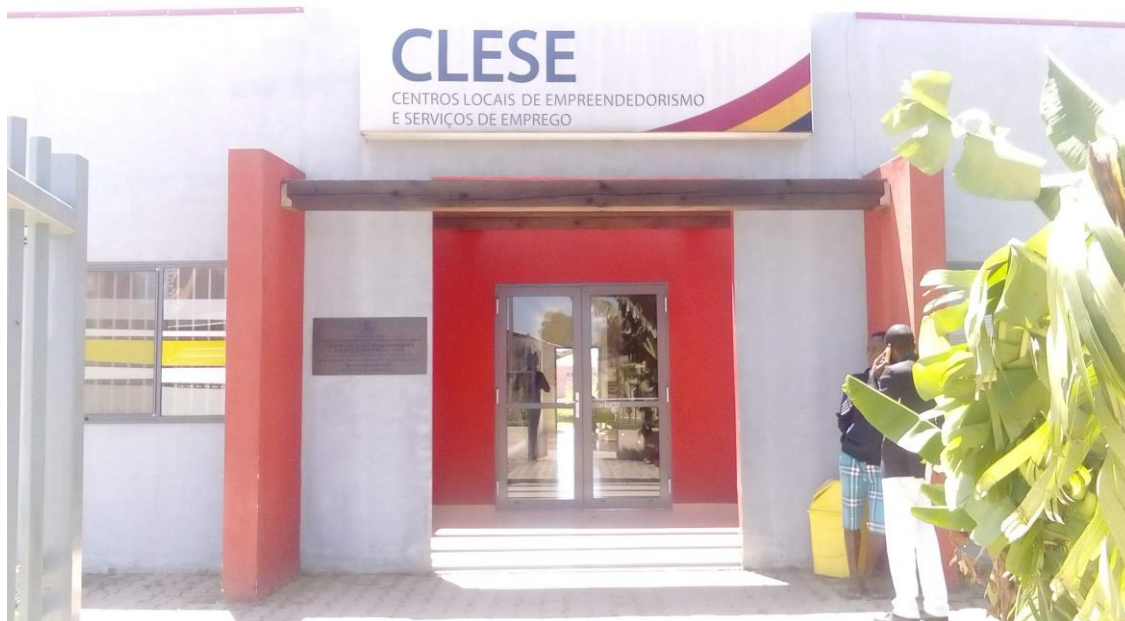
Figura C1. Parte externa das Instalações do Centro Locais de Empreendedorismo e Serviços de emprego no Moxico
