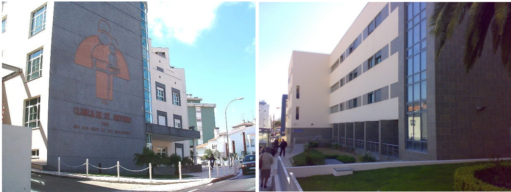
Figura 15 – CLISA da Amadora: edifício III e edifício IV
