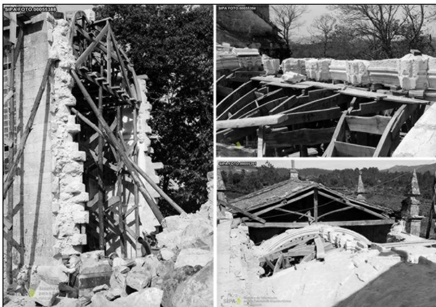
Figura 3. Obras de reconstrução da capela-mor, realizadas em 1941-1945. A) Andaime com a plataforma de trabalho ao nível dos *tas-de-charge*, onde são montados os cimbres. B) Extradorso da abóbada recoberta de alvenaria. C) O *rampante* longitudinal é horizontal, composto por vários segmentos curvos. Os cimbres das nervuras são talhados para colocação das chaves secundárias (DGPC).
