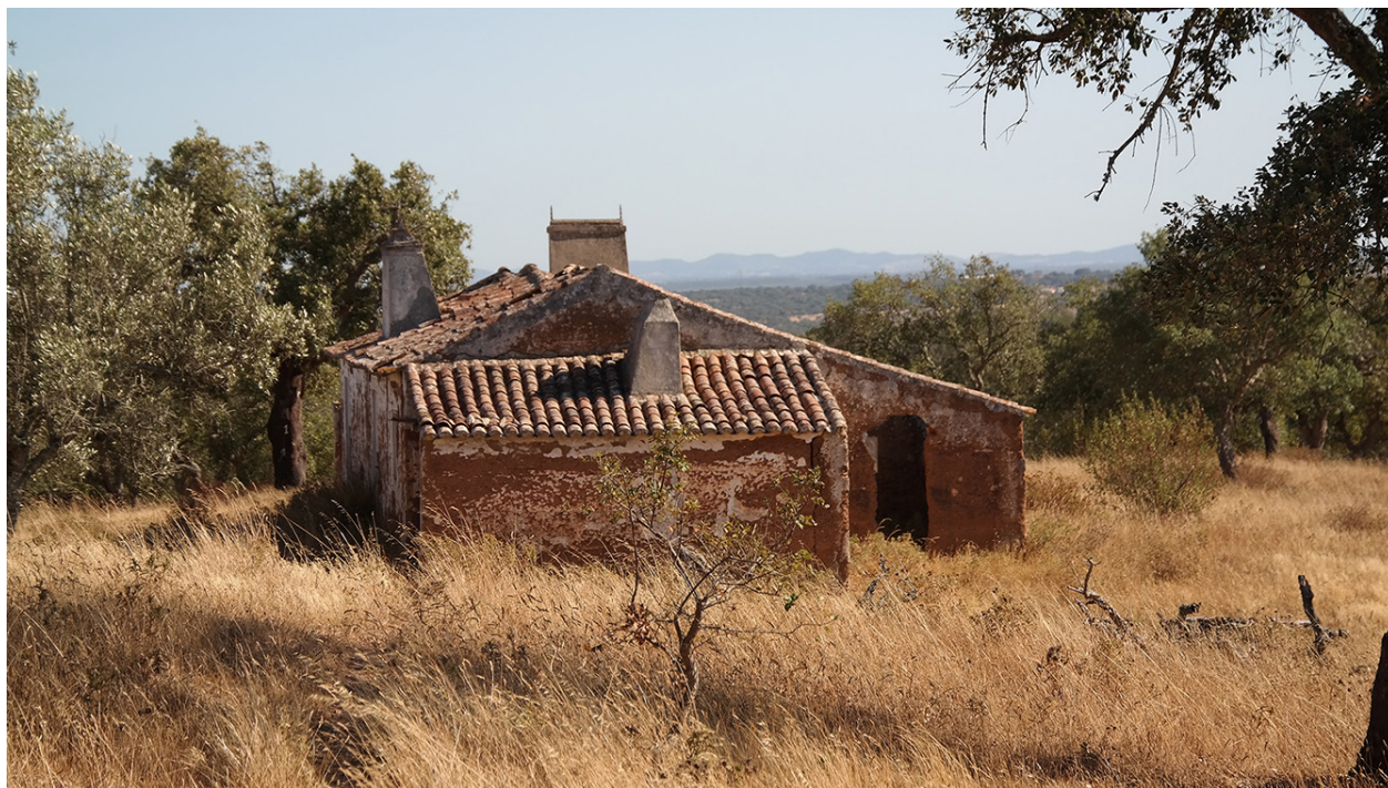
Figura 8 – Casa Acima, serra de Grândola. Vista do prolongamento do edifício na vertente do telhado para tardoz e forno adossado, 2015. Fotografia do autor cg
