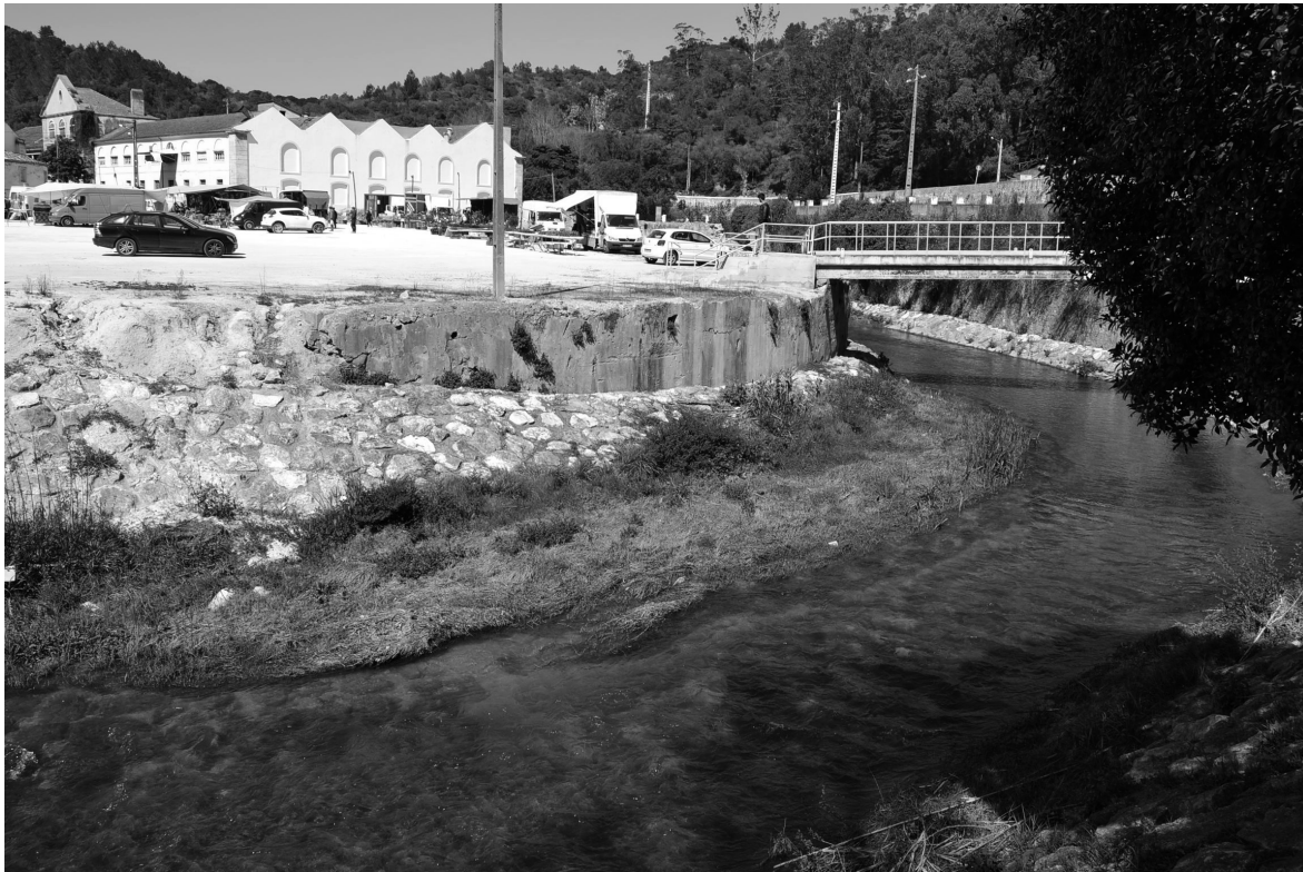
FIG.23 ANTIGA MOAGEM DE ALENQUER AREAL E PONTE PEDONAL
