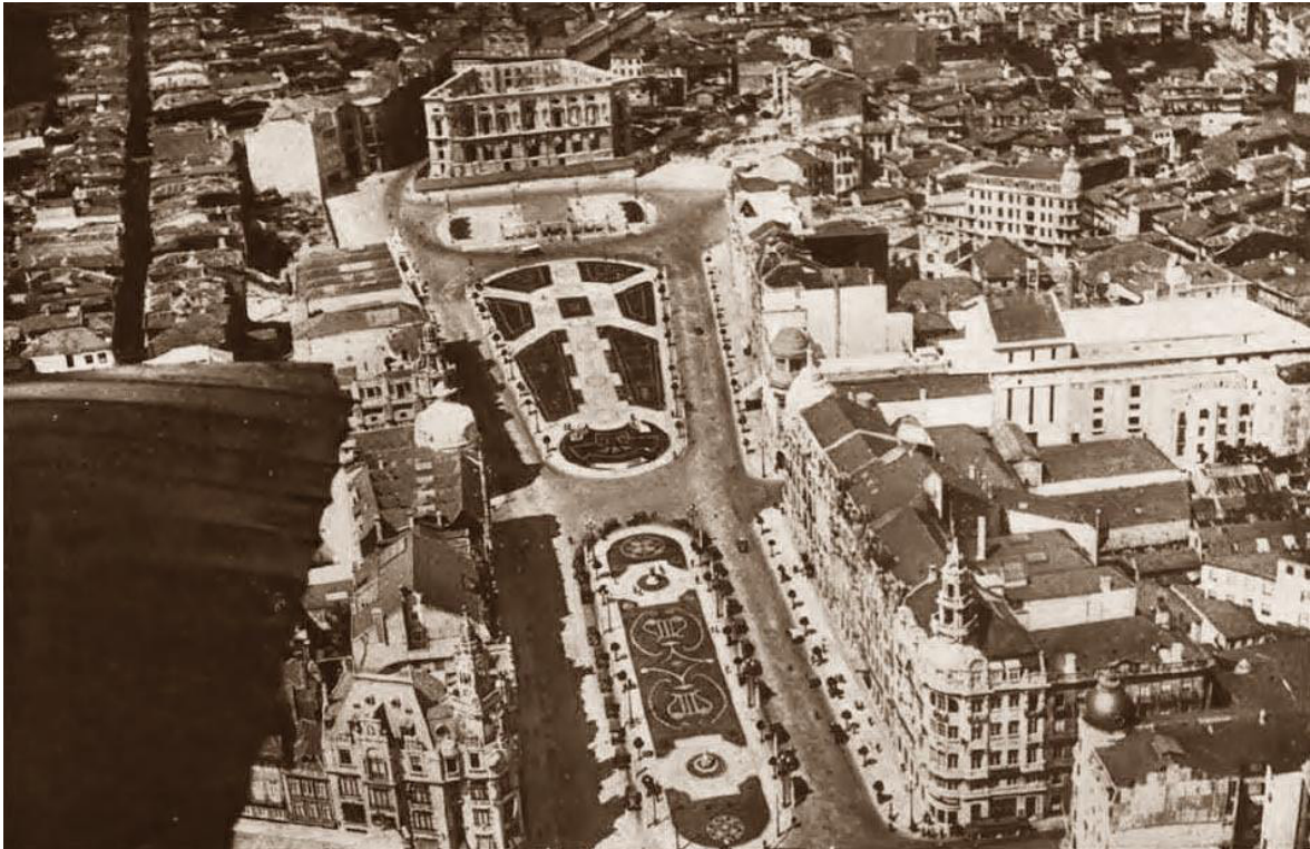
Figura 4 - Construção da Avenida dos Aliados, Porto, anos 30. http://3.bp.blogspot.com/-oupR3iBueQ4/UsieGuile7/AAAAAAAAHDY/DgyWqaLTENY/s1600/Porto%252C+Avenida+dos+Aliados+-+Alv%25C3%25A3o.jpg
