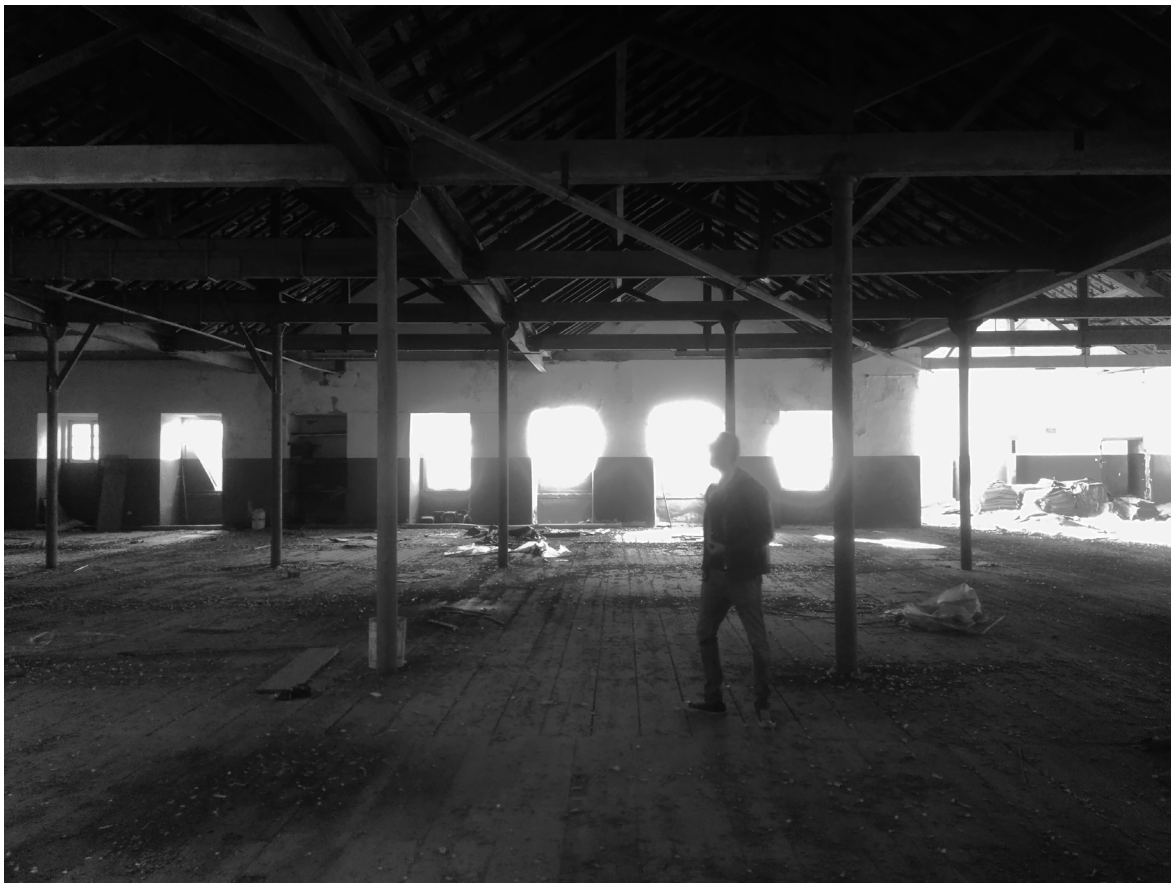
FIG.33 ANTIGA MOAGEM DE ALENQUER ARMAZÉM PISO 1
