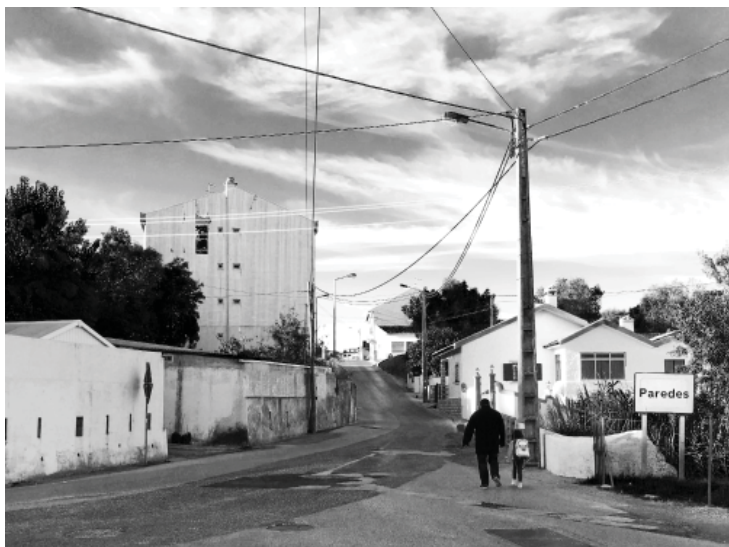
Figura 18. A ausência de passeios leva os peões a deslocarem-se na mesma faixa da via que os automóveis
