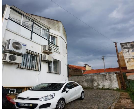
Figura 30 - Traseiras do edifício
