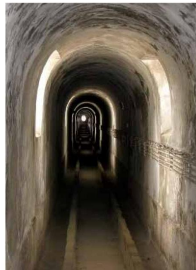
07 e 08 - em cima uma vista do interior do aqueduto das águas livres e a baixo vista do aqueduto no vale de alcantara
