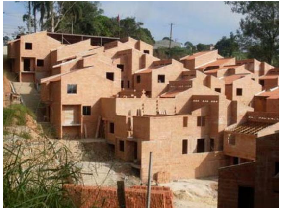
Figura 13 Imagem da obra em andamento (2010) Fonte: Arquivos USINA-CTAH
