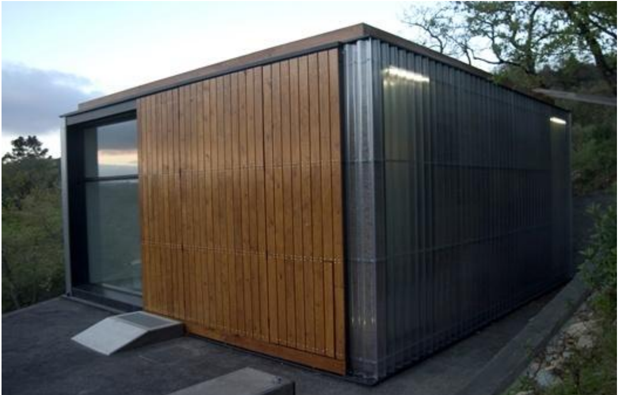
Figura 10 - Casa em Arruda dos Vinhos, Plano B arquitectos. http://arquitecturadesignetc.blogspot.pt/2011/04/plano-b-casa-em-arruda-dos-vinhos.html
