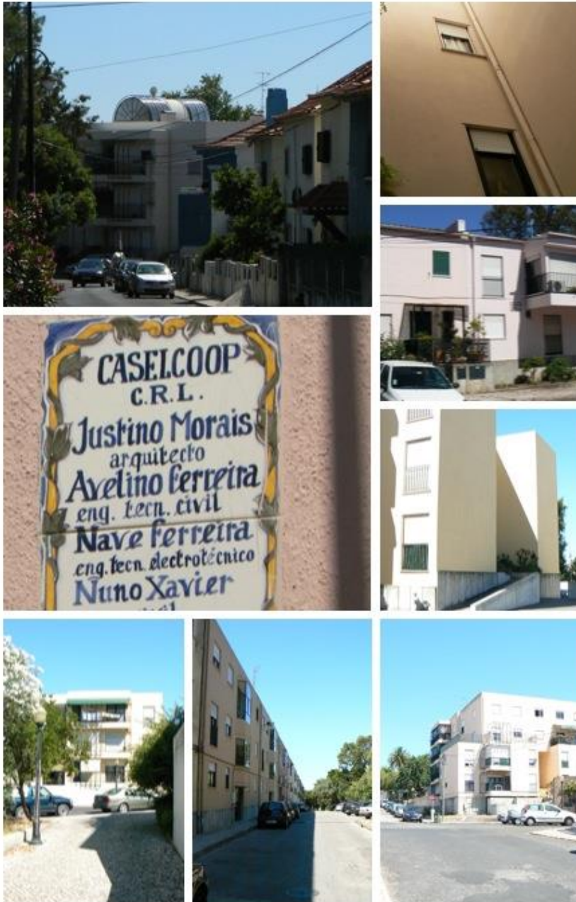
Imagem 39| Vistas do conjunto habitacional Caselcoop em Caselas.
