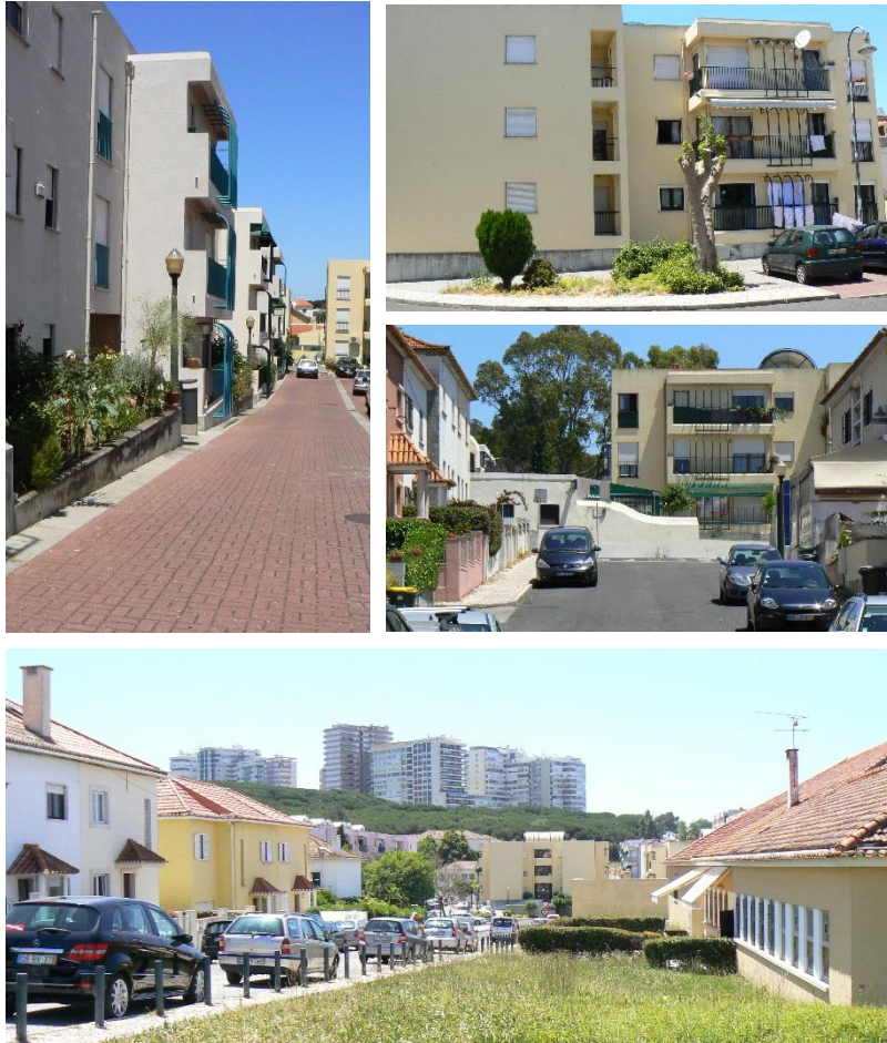
Imagem 23 | Fotografias do conjunto habitacional Caselcoop. Fonte: Fotografias da autora.
