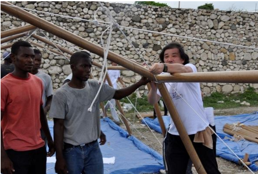
Fig. 3 - Shigeru Ban a construir habitações de emergência com a população local, após terramoto no Haiti. Projeto de 2010
