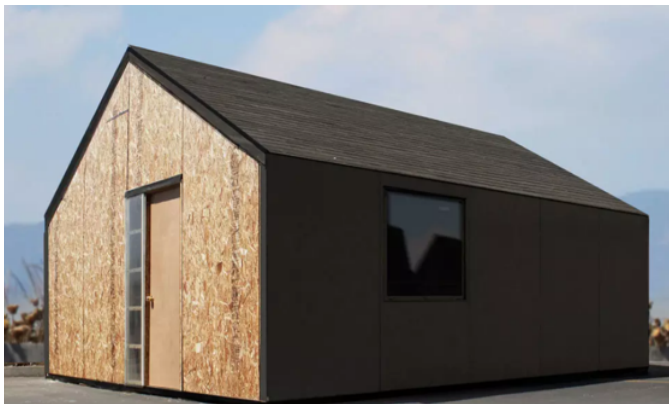
Fig. 22 - Abrigo de Emergência, Chile, projetado por Elemental, em 2014
