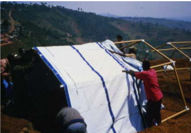
Fig. 15 - Montagem abrigos de emergência, Ruanda, Shigeru Ban. 1995
