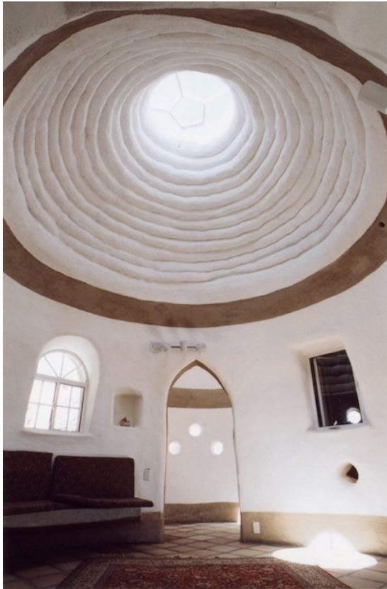
Fig. 25 - Habitação em abóbada, apresenta alta resistência sísmica, projeto de Call Earth
