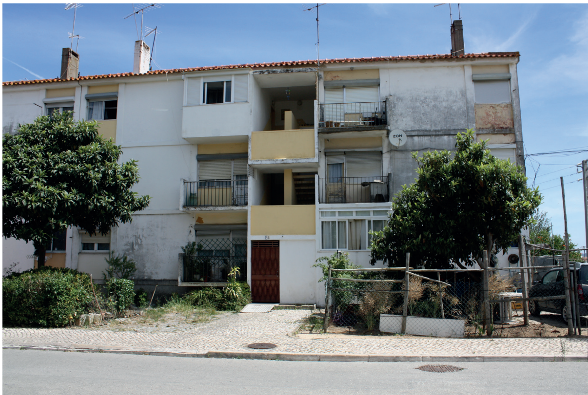
Fachada principal, Bloco Norte
