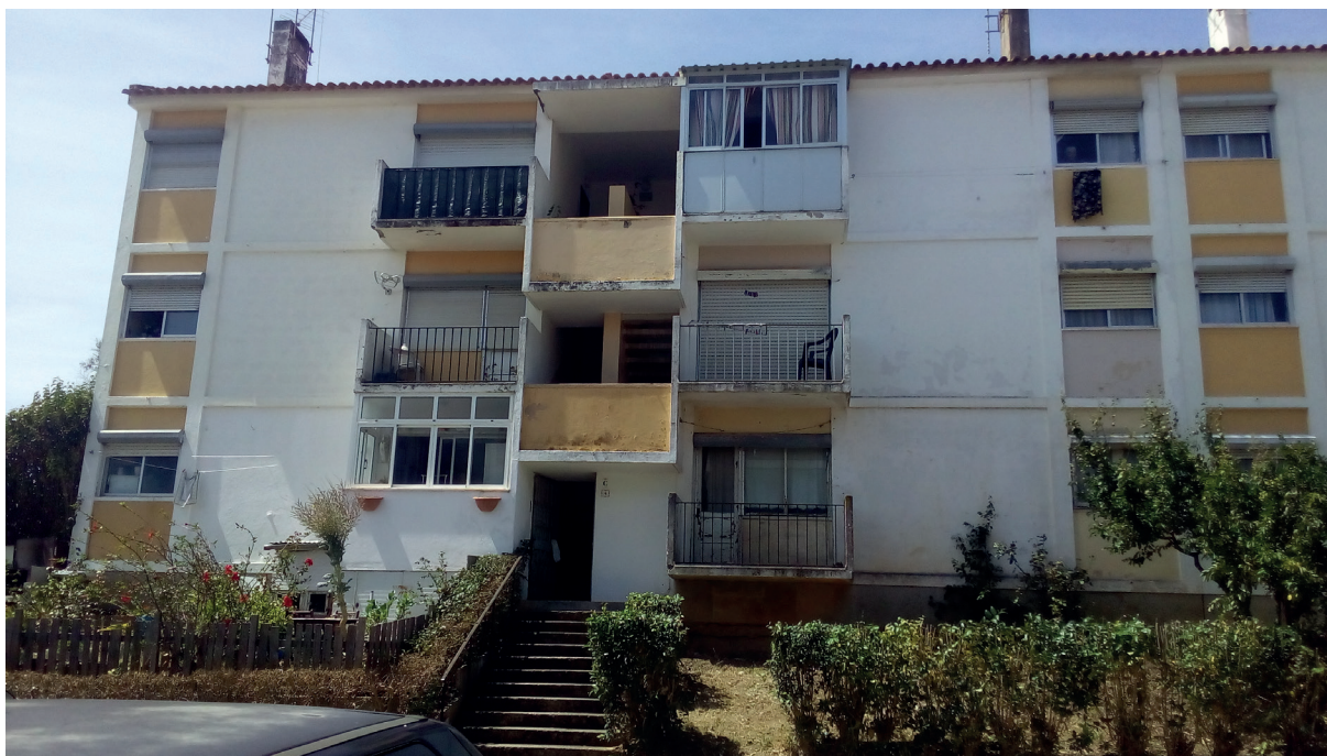
Fachada principal, Bloco Sul
