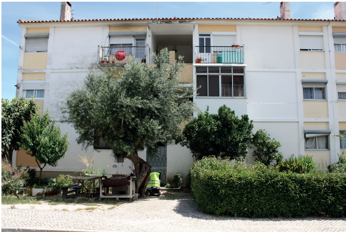
Fachada principal, Bloco Norte
