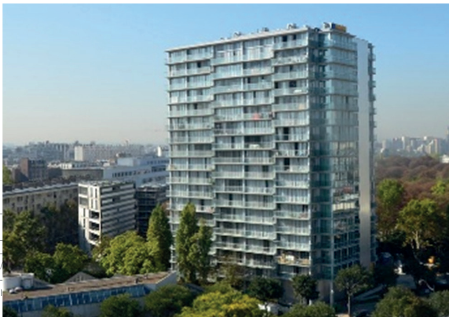
Figura 15- Torre Bois le Prêtre, França, edifício depois da reabilitação. Fonte: Domus, Intelligent architecture for current times, 2012. Disponível em: http://www.domusweb.it/en/architecture/2012/02/03/intelligent-architecture-for-current-times.html . Acesso em: Agosto de 2017.
