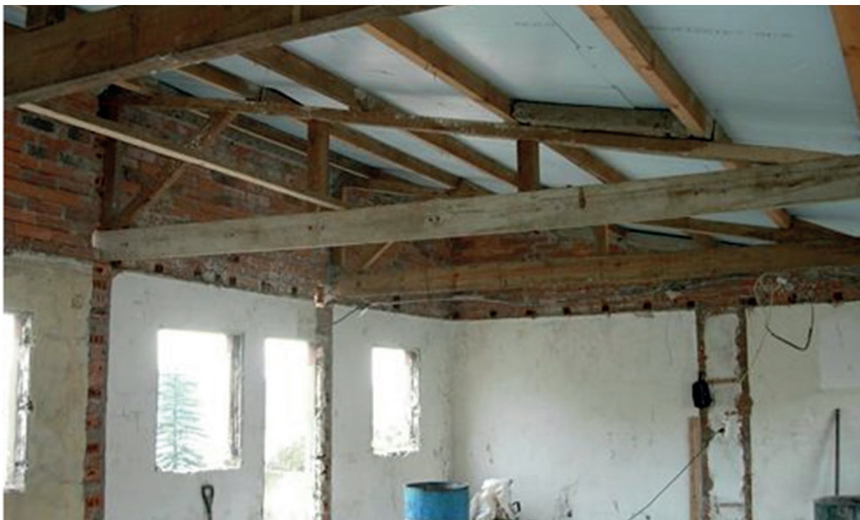
Figura 10- Decurso das obras no interior da habitação, Bairro D a Leonor, Porto.
