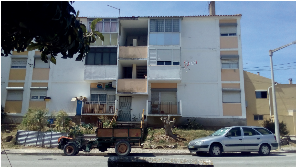
Fachada principal, Bloco Sul
