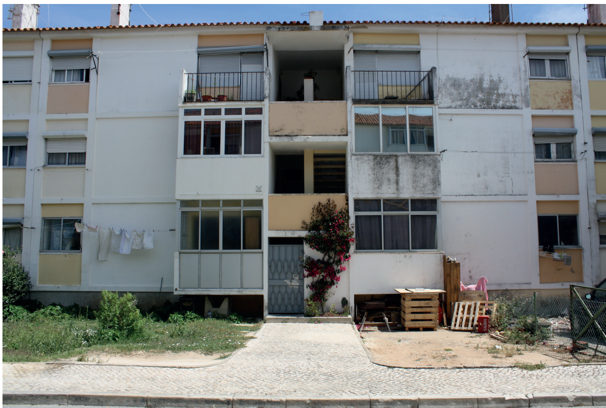
Fachada principal, Bloco Norte
