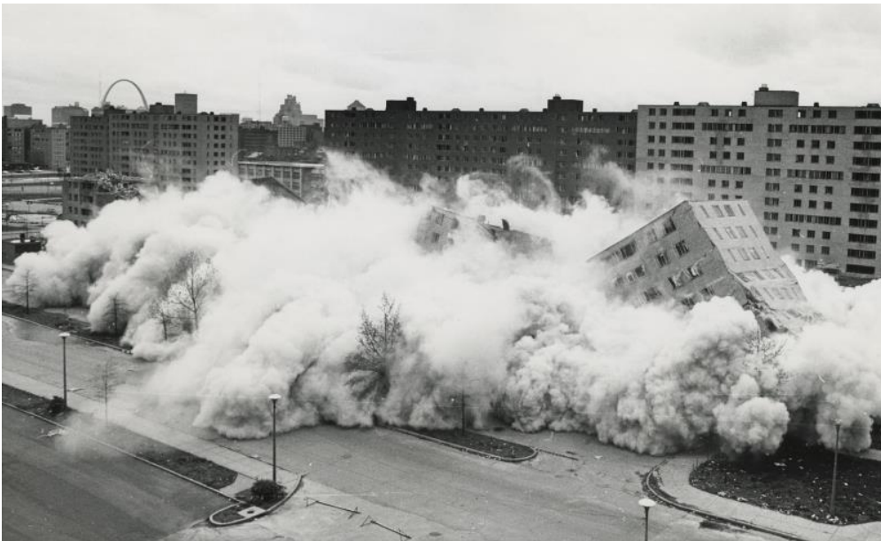
Figuras 38-39. Pruitt-Igoe, projecto de, Minoru Yamasaki, totalmente construído e em demolição.
