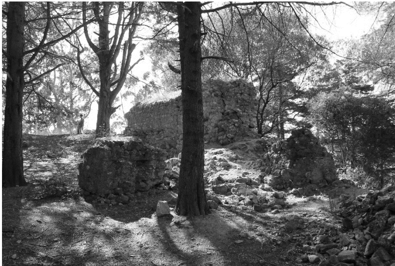
Ruína do Castelo – parede norte.
