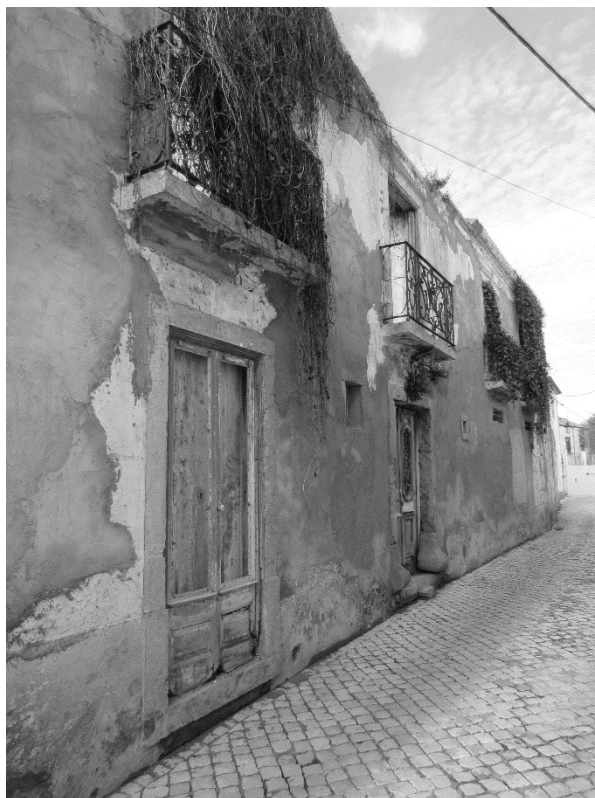
Vista do exterior do quarteirão. Estado da fachada sudeste.
