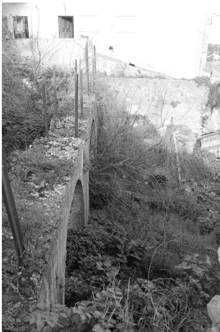
Vista do interior: a parede arcada.
