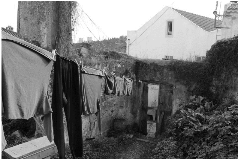
Vista do interior do quarteirão. Estado da fachada sudoeste.
