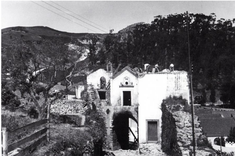
Obras de reconstituição da Mralha do Castelo.
