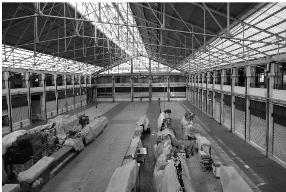
Fig. 75: Interior do mercado, antes da intervenção.
