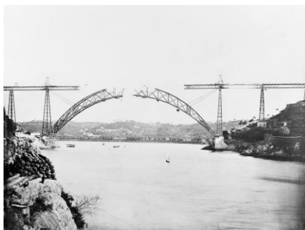
Figura 18: Construção da Ponte D. Maria Pia, 1877. Gustave Eiffel
