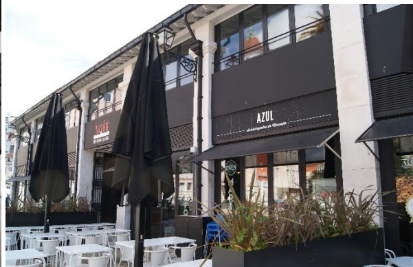
Fig. 81: Alçada poente, após a intervenção.
