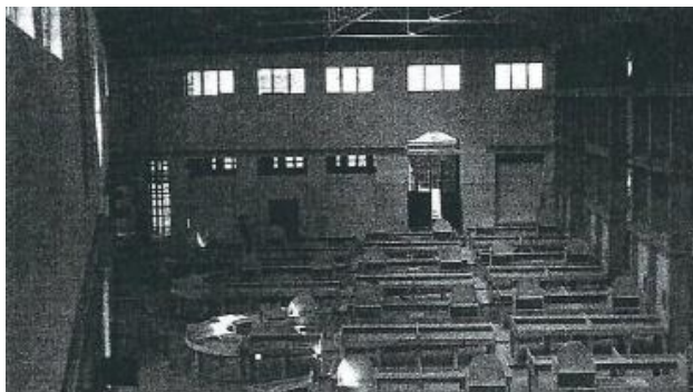
Fig. 101: C - Nave Sul do mercado, 1980.
