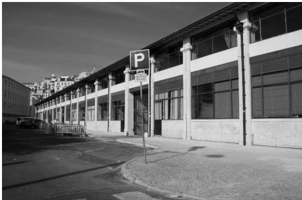
Fig. 80: Alçada poente, antes da intervenção.
