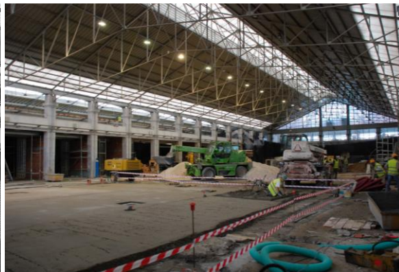
Fig. 76: Interior do mercado, durante as obras
