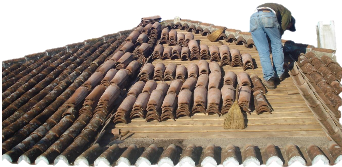
Figura 32- Telha regional de argila local na Quinta do Espírito Santo. Instrumentos de trabalho também específicos.
